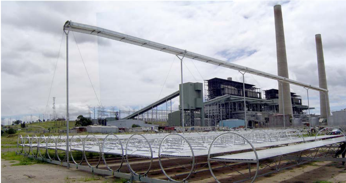
Figura 25. Figura 23: Prototipo de CLF existente en la Central eléctrica de carbón de Liddell (Australia)
