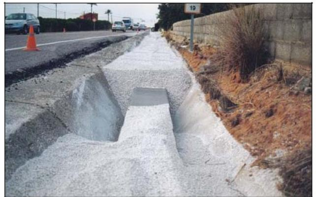
Figura 22. Dren filtrante. Actuación de nivelación de cuneta en Alzira.
