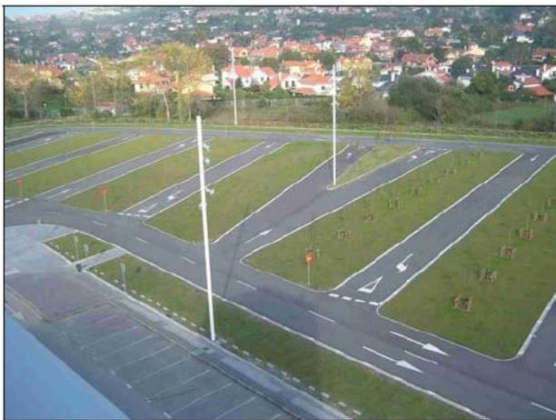
Figura 19. Aparcamiento permeable en Gijón.
