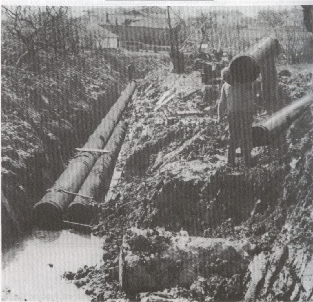
Fig. 5-25. Colocación de tubería de PVC.
