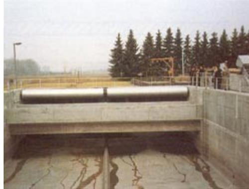
Fig. 8. Sistema de limpieza mediante un depósito volteador.
