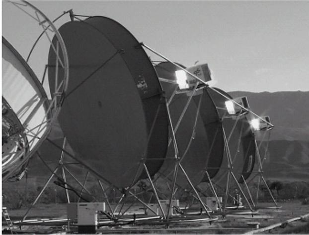
Figura 10. Vista lateral de las tres unidades DISTAL-II de la PSA, fabricadas por la empresa alemana Steinmüller y con el motor SOLO 161 solar en el año 1996. Cada unidad tiene un diámetro de 8,5 m y una potencia eléctrica bruta de 10 kW.
