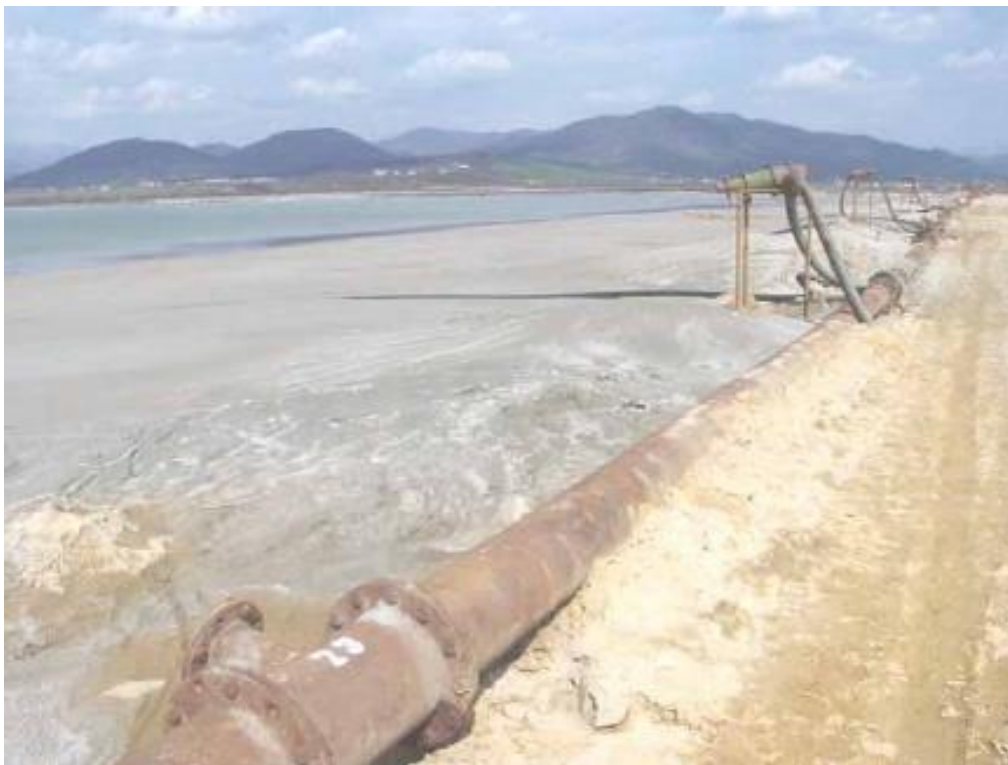
Fig. 4: Imagen de una balsa de estériles (AURUM Dam, Baia Mare, Rumania)
