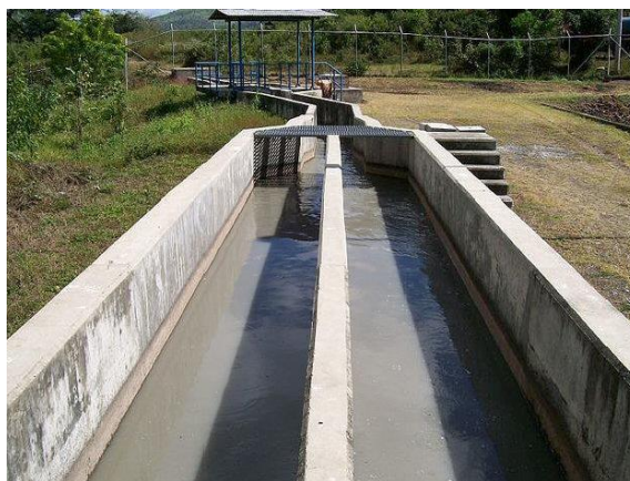
Figura 6.7. Canal desarenador de hormigón.
