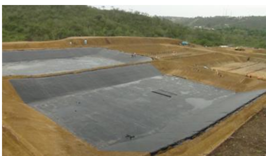
Figura 6.10. Revestimiento con material plástico del fondo de la laguna.
