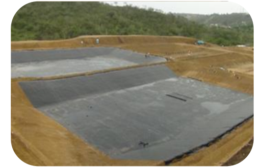
Impermeabilización de fondo y taludes
