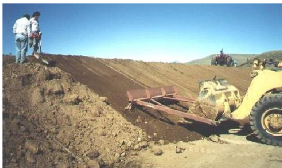
Figura 6.9. Estabilización de taludes.
