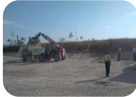
Excavación y movimiento de tierras
