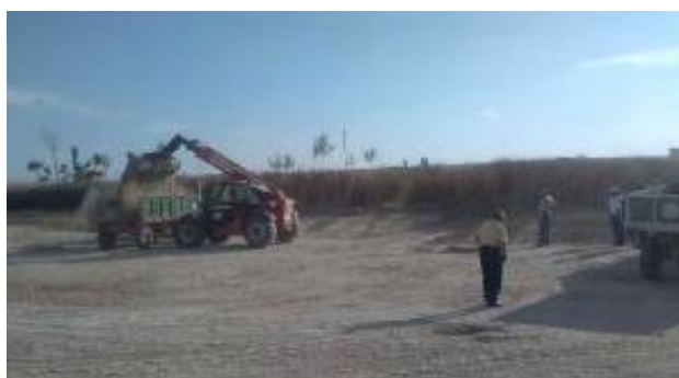
Figura 6.8. Movimiento de tierras en la construcción de lagunas.
