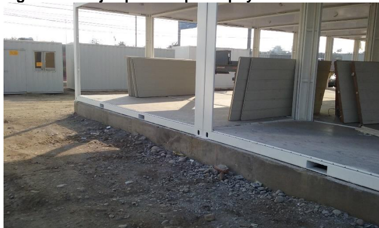
Figura N° 9. Ejemplo losa para apoyo de contenedores
