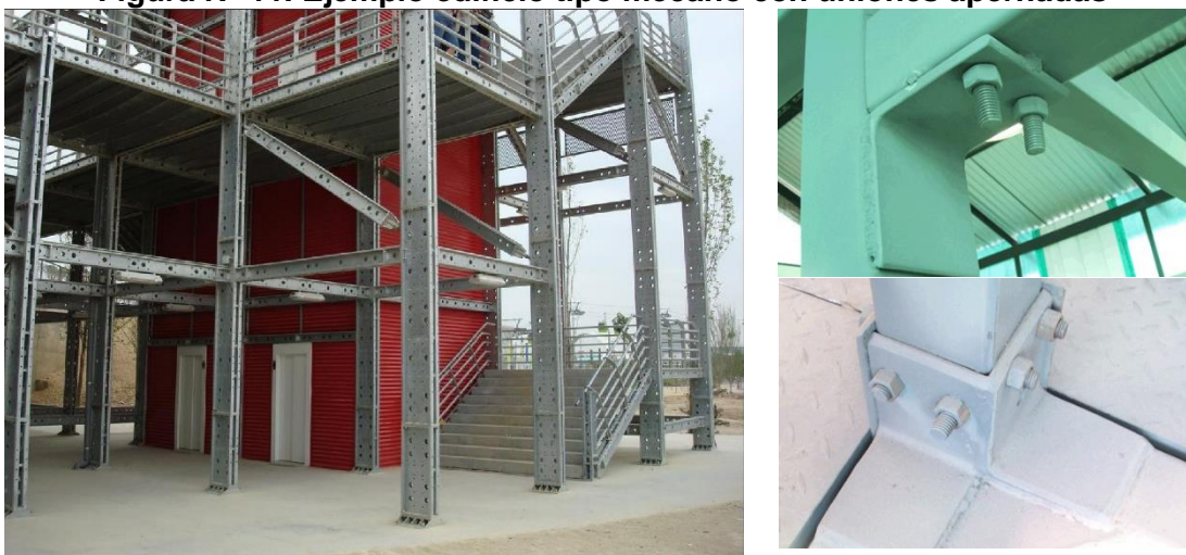
Figura N° 11. Ejemplo edificio tipo mecano con uniones apernadas
