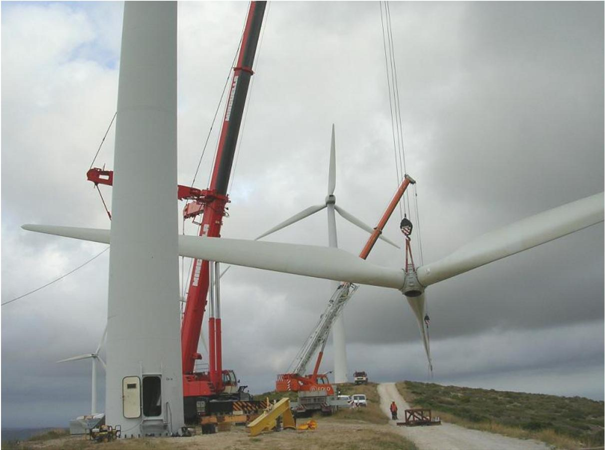
Ilustración 128: Montaje de aerogenerador
