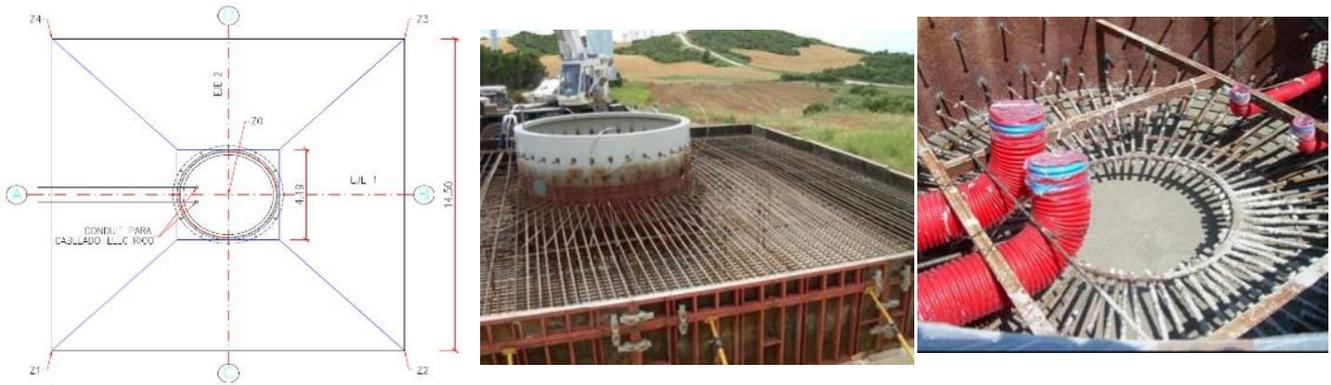
**Ilustración 124: Cimentación superficial del aerogenerador**
