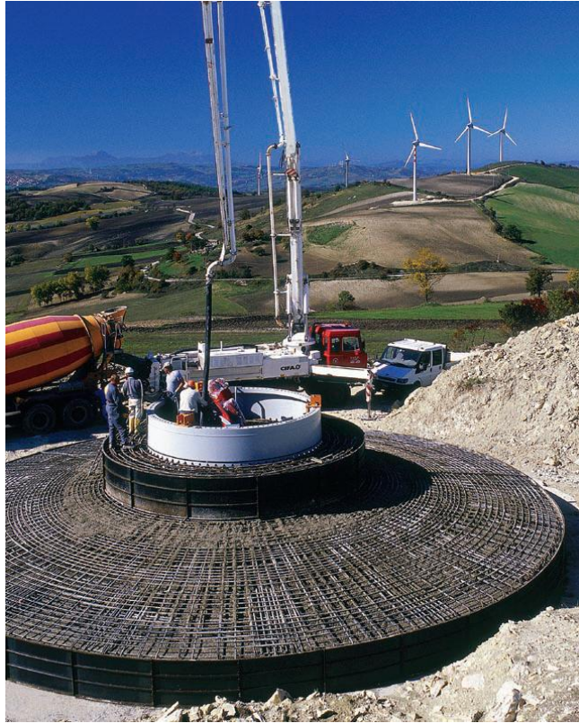
Figura 46. Cimentación de un aero.
