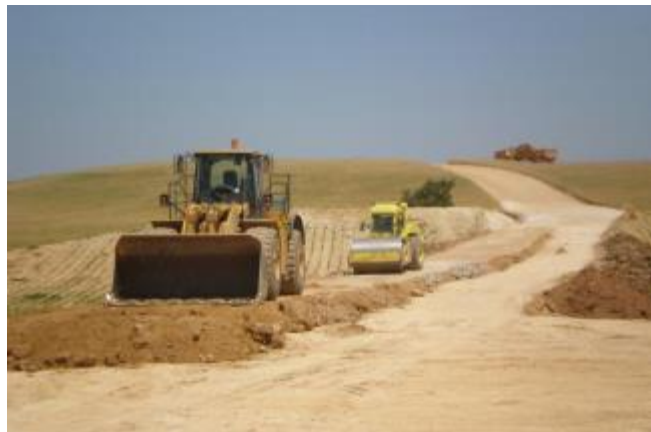
Figura 42. Compactación de viales
