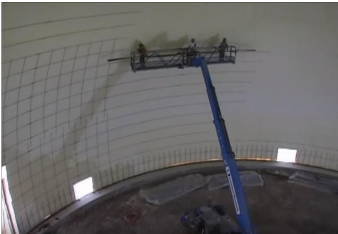
Gráfico 17: Colocación de refuerzo de acero estructural
