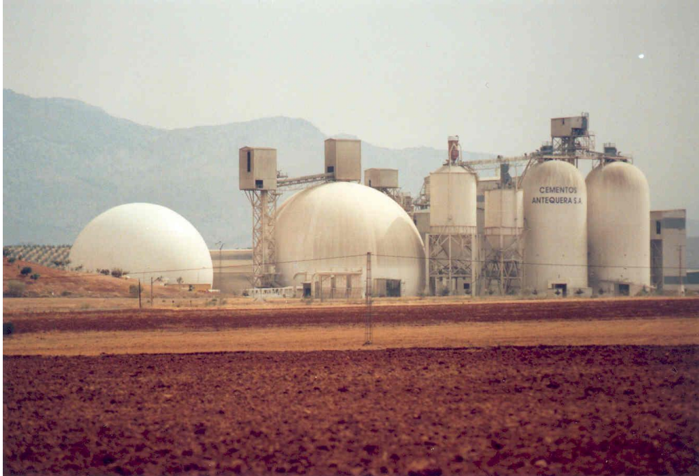
Gráfico 27: Domos para almacenamiento de clínker y cemento. Málaga, España.
