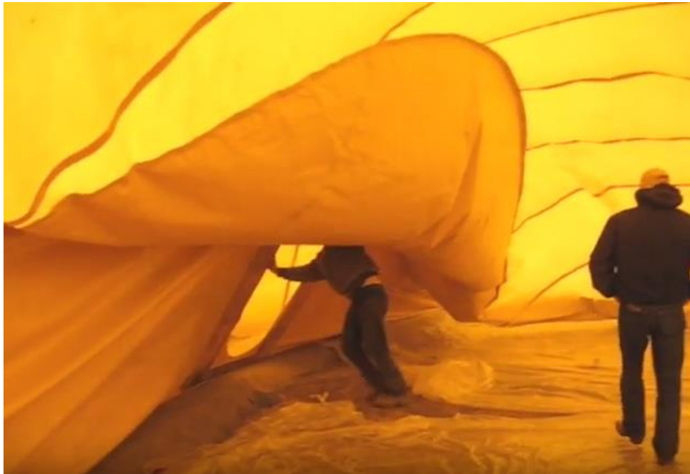
Gráfico 14: Membrana en proceso de presurización
