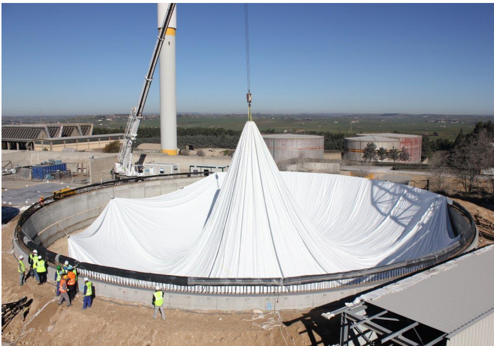
Gráfico 11: Fijación de membrana en el perímetro
