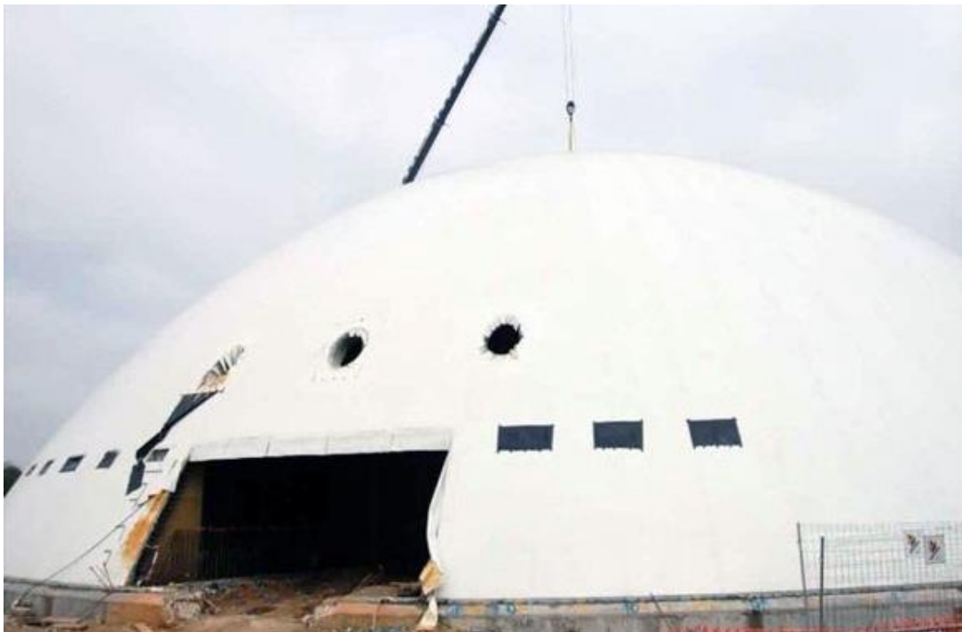
Gráfico 20: Replanteo y apertura de puerta
