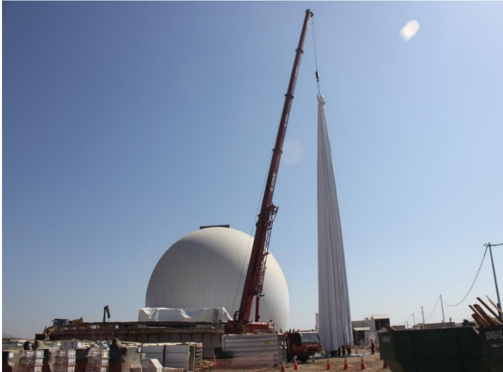
Gráfico 10: Extendido de membrana inflable
