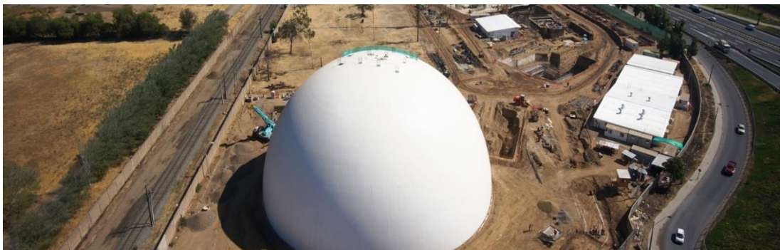
Gráfico 32: Arriba, Domo para terminal de embarque de cemento en N. Zelanda. Lafarge-Holcim. Abajo, Domo para clínker en Santiago de Chile. BSA Cementos.
