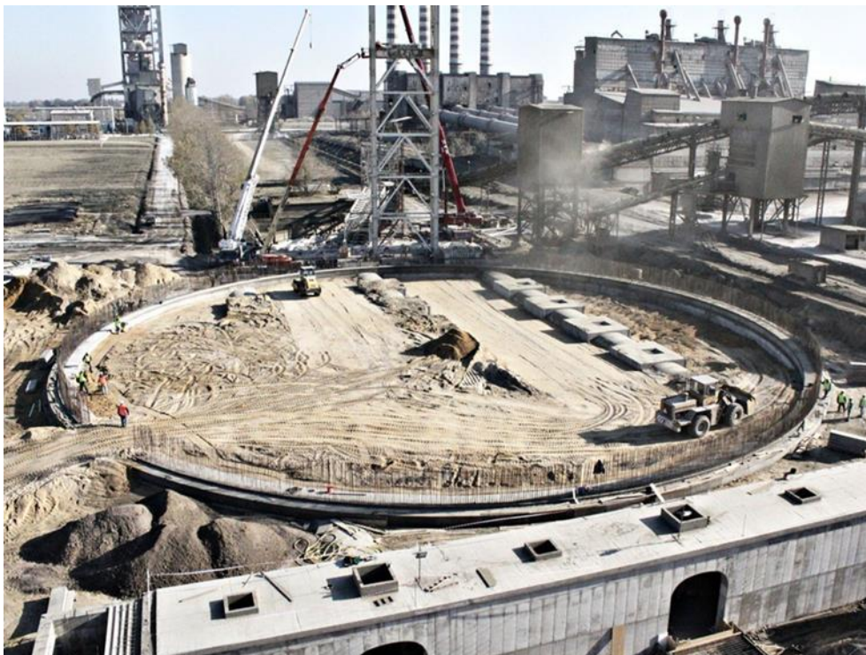
Gráfico 9: Construcción de cimentación y túneles de descarga
