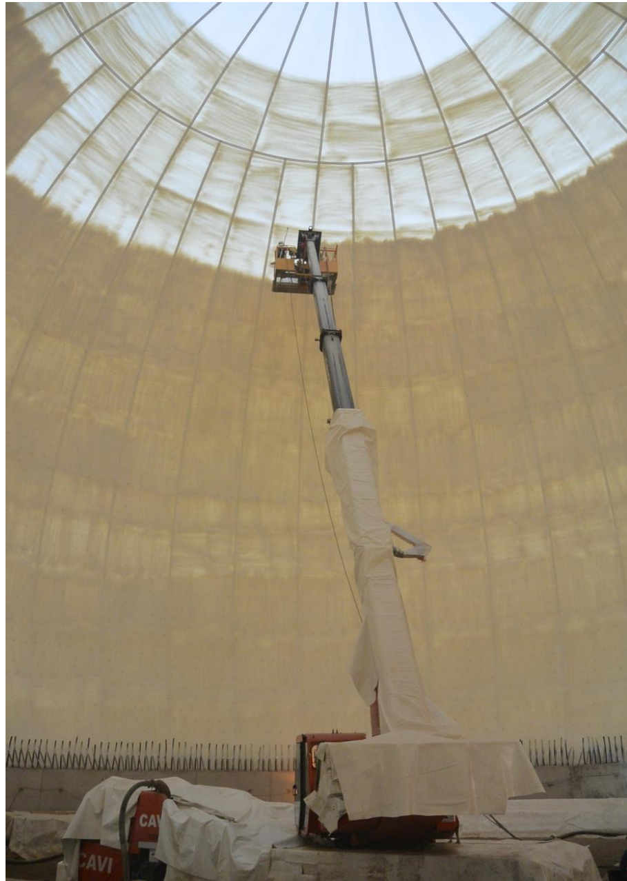
Gráfico 16: Proyección de espuma rígida de poliuretano
