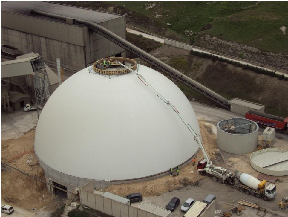
Gráfico 19: Hormigonado de losa superior de Domo
