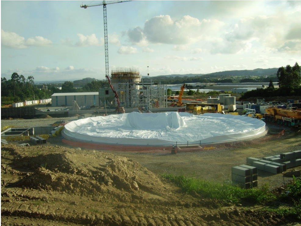
Gráfico 12: Membrana lista para ser presurizada
