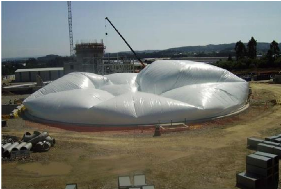
Gráfico 13: Membrana en proceso de presurización
