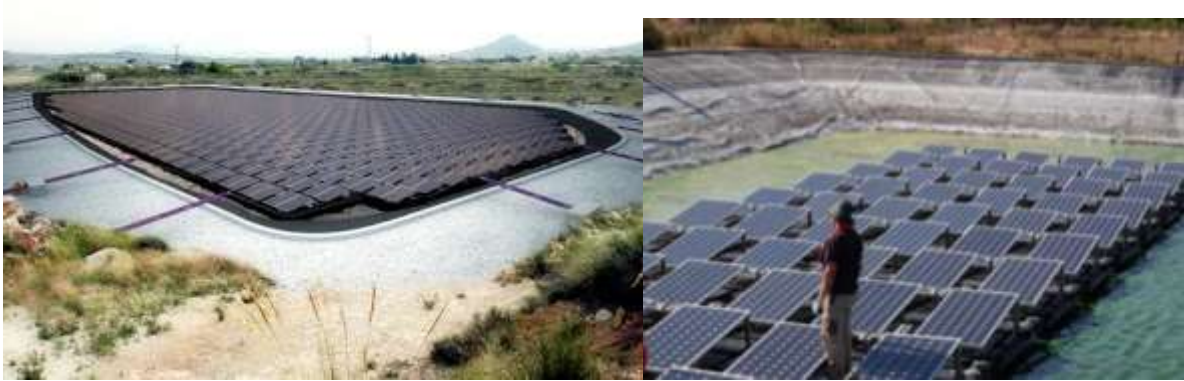
Figura 9.18. Paneles fotovoltaicos flotantes sobre balsas artificiales.
