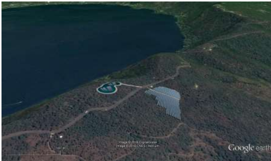
Figura 9.23. Situación de los paneles fotovoltaicos.
