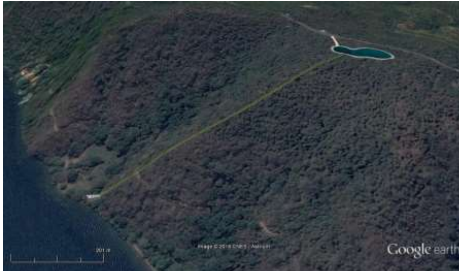
Figura 9.15. Depósito, tuberías y casa de máquinas.
