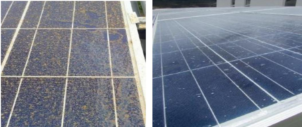
*Figura 88: Suciedad en módulos fotovoltaicos. (Fuente: Google images).*
