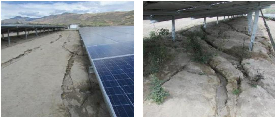
*Figura 87: Erosión del terreno de un parque fotovoltaico. (Fuente: Google images).*
