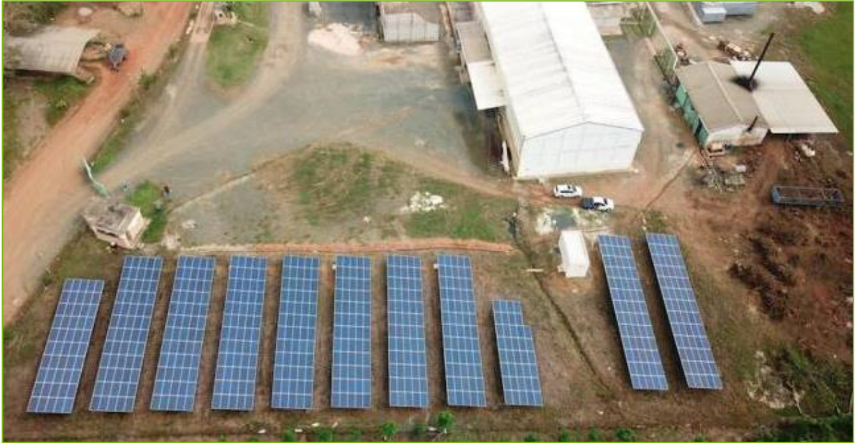
Imagen 35: Sistema fotovoltaico híbrido, Citrícola del Este. Fuente: Periódico Diario Libre.
