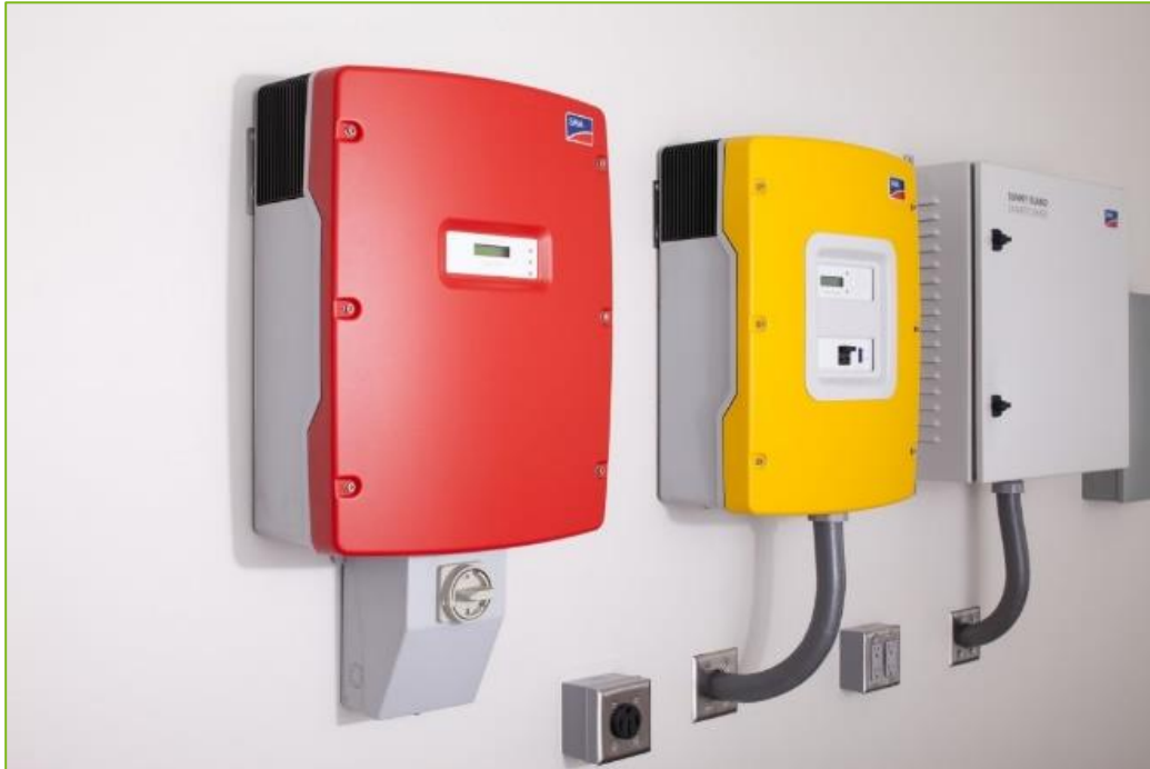
Imagen 10: Inversores fotovoltaicos. Fuente: Google images | SMA Solar.
