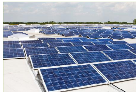
Imagen 56: Módulo fotovoltaico en disposición vertical.
