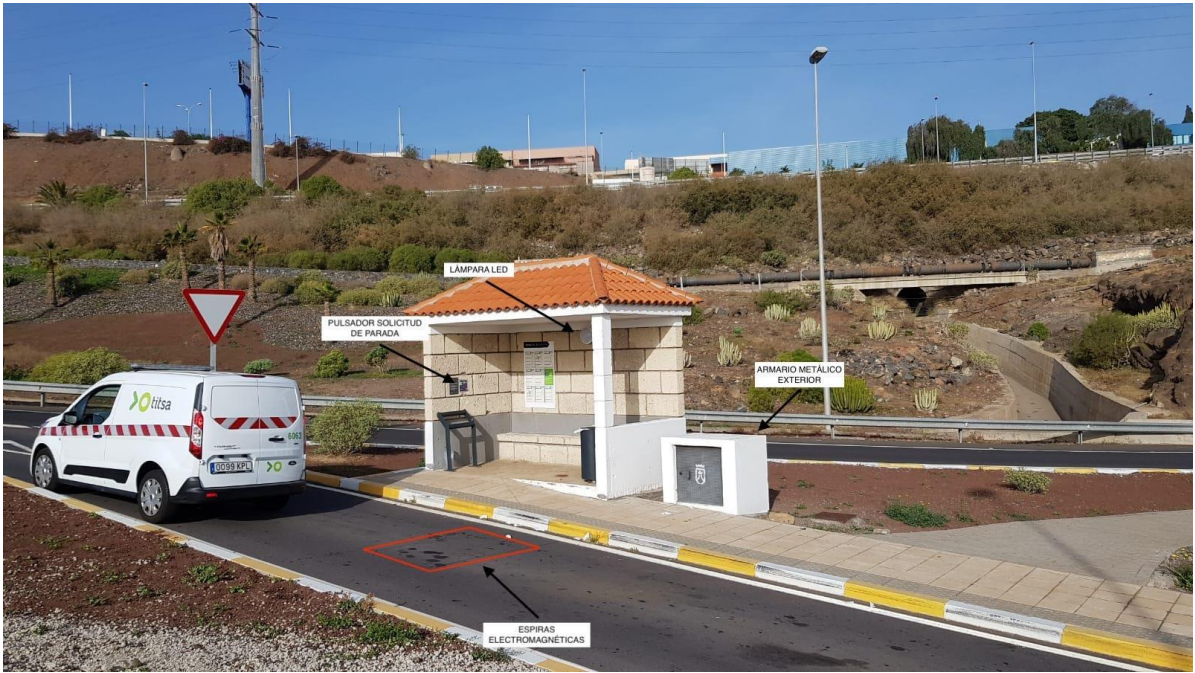
Ilustración 13. Elementos del Sistema Actual en Parada
