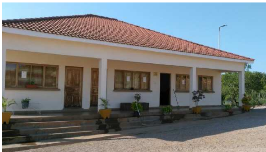
Figura 14.8. Imagen de las oficinas.
