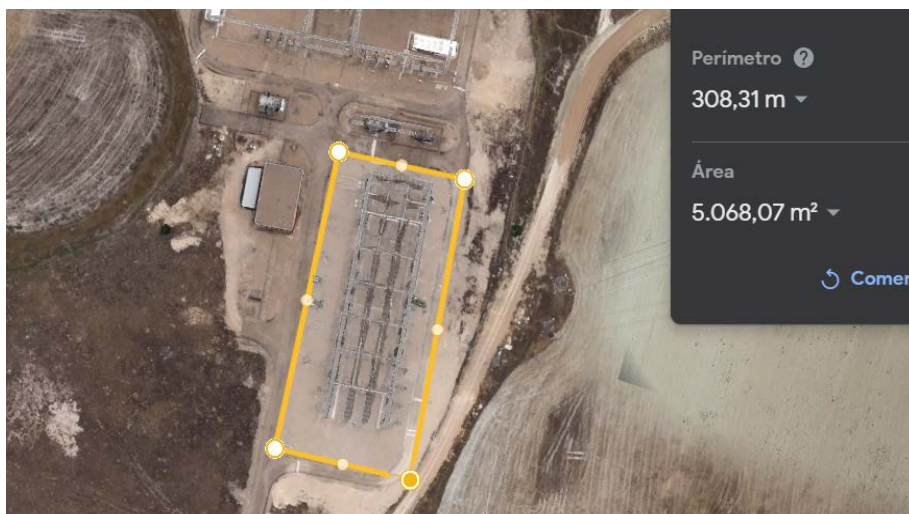
Imagen aérea ST Renedo (Valladolid). Fuente: Google Earth
