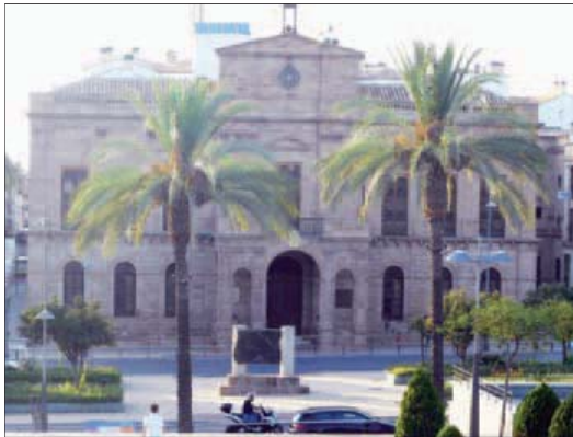
EN OBRAS. Panorámica del antiguo edificio del Ayuntamiento.
