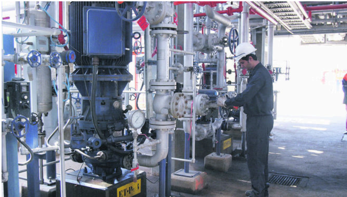
Un operario de Cepsa gira una llave en la planta de biocombustible. / H.I. (Huelva)
