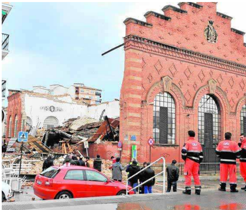
Estado en el que quedó el mercado de abastos tras el derrumbe sufrido en marzo por el fuerte viento.
