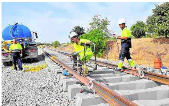
Operarios trabajan en la construcción del ramal de Vadollano.
