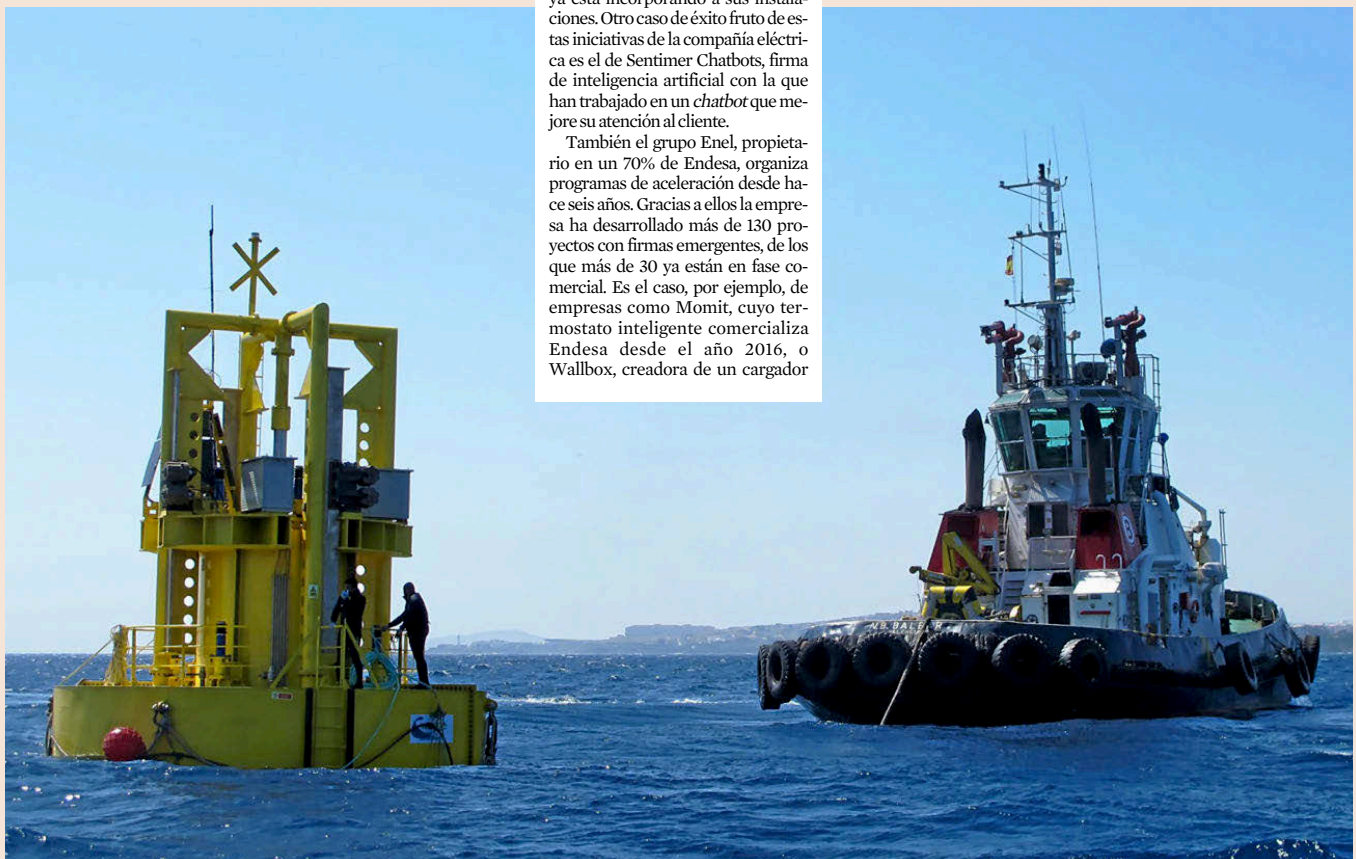
La 'start up' Wedge Global ha desarrollado una tecnología que permite generar energía eléctrica a partir de las olas del mar. En la imagen, el dispositivo que han instalado junto a las Islas Canarias.
