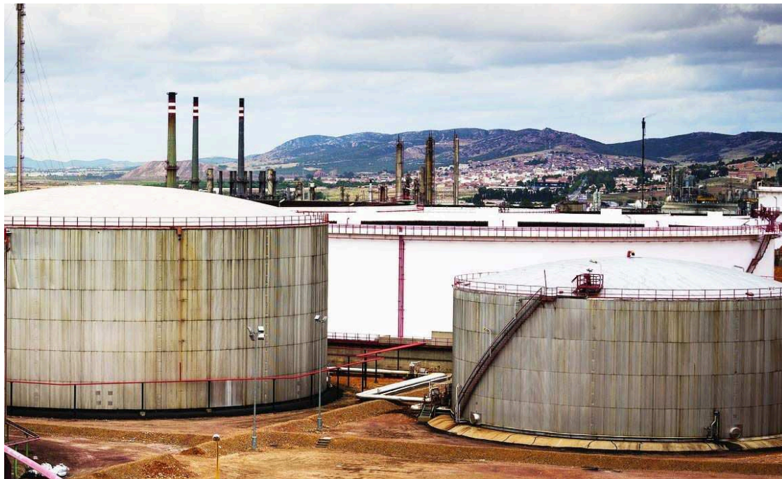
Repsol reparará tres tanques de almacenamiento / Lanza
