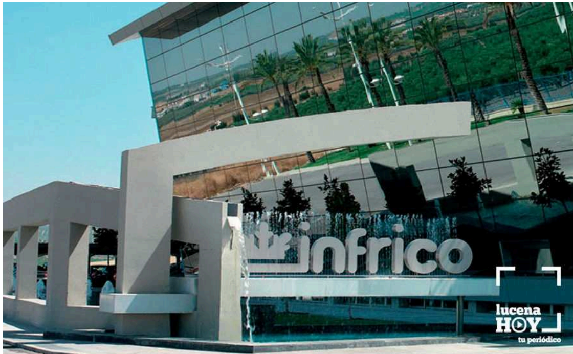
Instalaciones de la firma lucentina INFRICO
