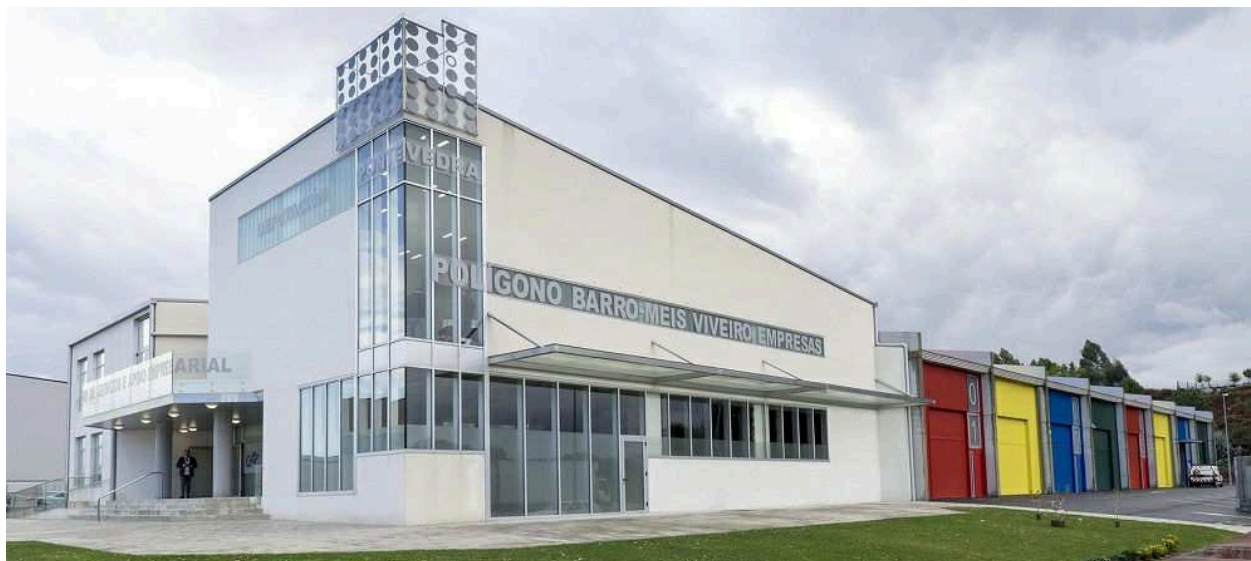
Instalacións do Coworking e viveiro de empresas de Barro-Meis. Foto: Anxo Iglesias
