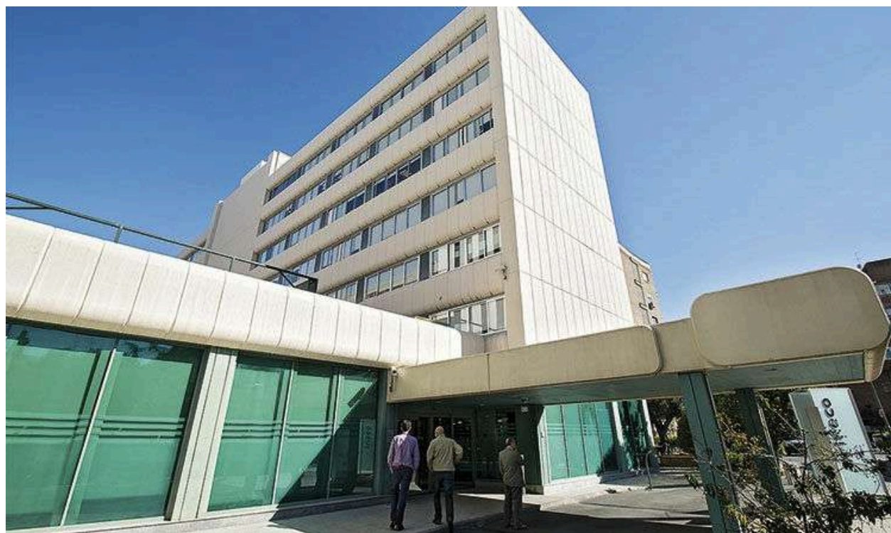
Edificio de Ineco en el Paseo de la Habana (Madrid).
