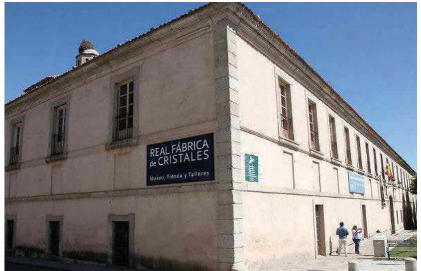
Exterior de la Real Fábrica de Cristales de La Granja, emblema de la arquitectura industrial del siglo XVIII. / D. M.
