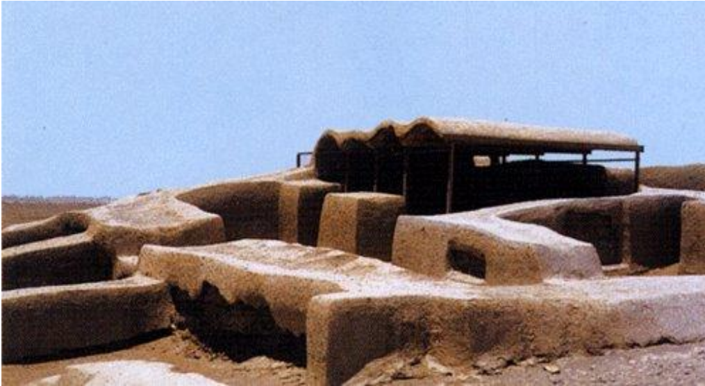
Imagen 14: Construcción con adobe
