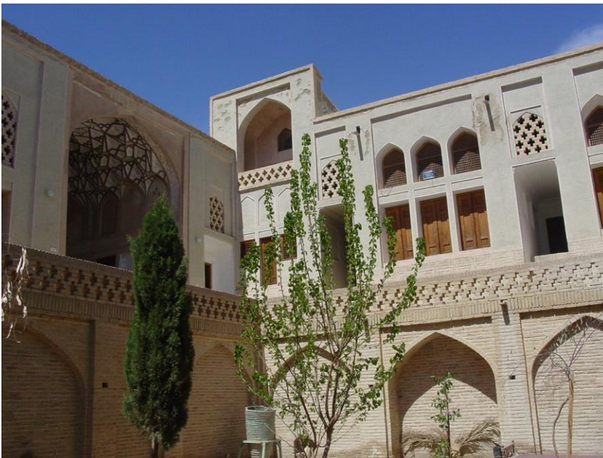
Imagen 35: Vivienda en Nain (Irán). Fuente: Mansiones of Isfahán
