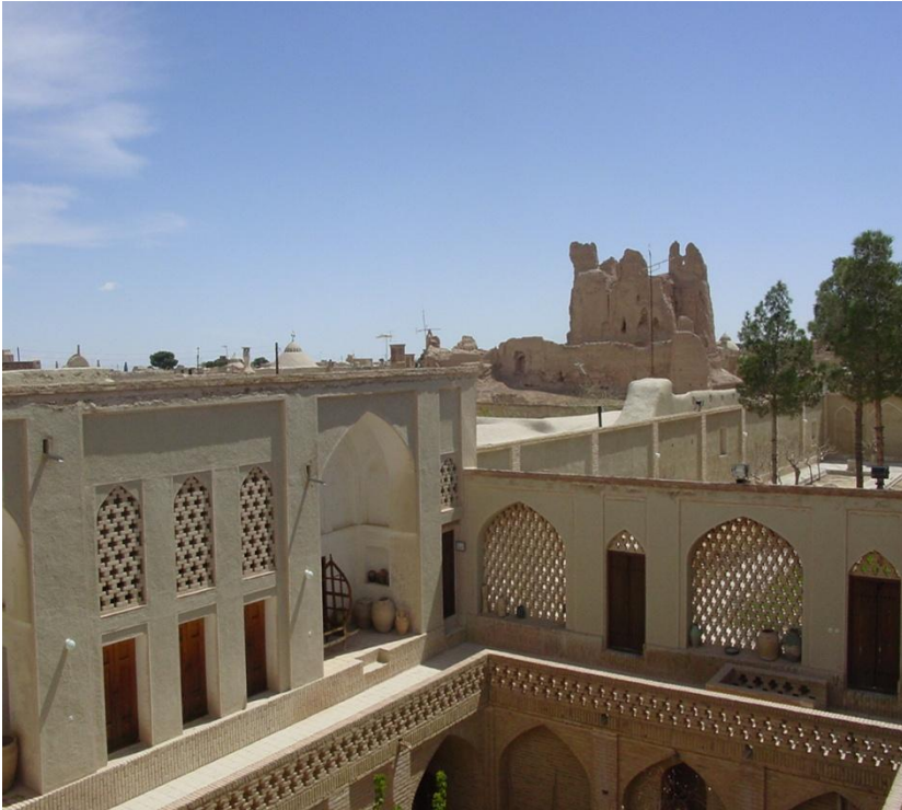
Imagen 34: Vivienda en Nain (Irán) Fuente: Mansiones of Isfahán
