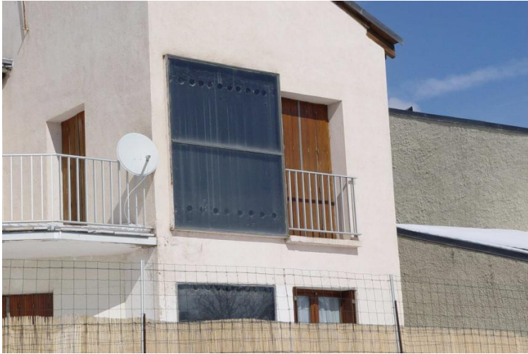
Imagen 11: Ejemplo de Muro Trombe en vivienda unifamiliar.
