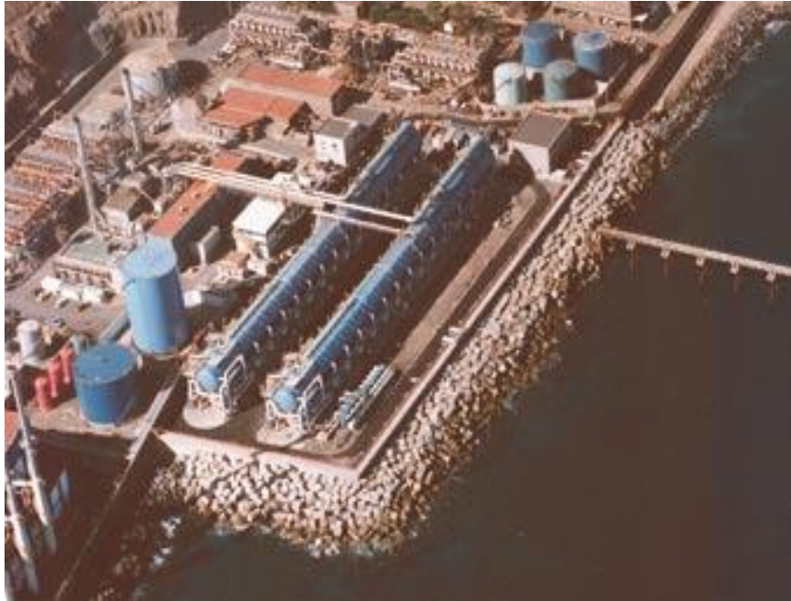
Conjunto de plantas de desalación por destilación en Gran Canaria.
