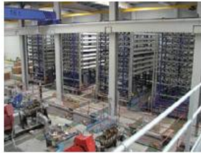
Figura 30. Vista general de una desaladora I. Por cortesía de AEDYR
