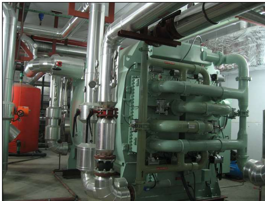
FIGURA 6.12. VISTA DE UNA MÁQUINA DE ABSORCIÓN EN UN POLIDEPORTIVO DE LA COMUNIDAD DE MADRID
