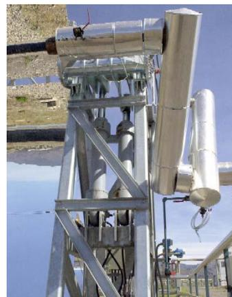
*Figura 62: Detalle de los accionamientos hidráulicos*
