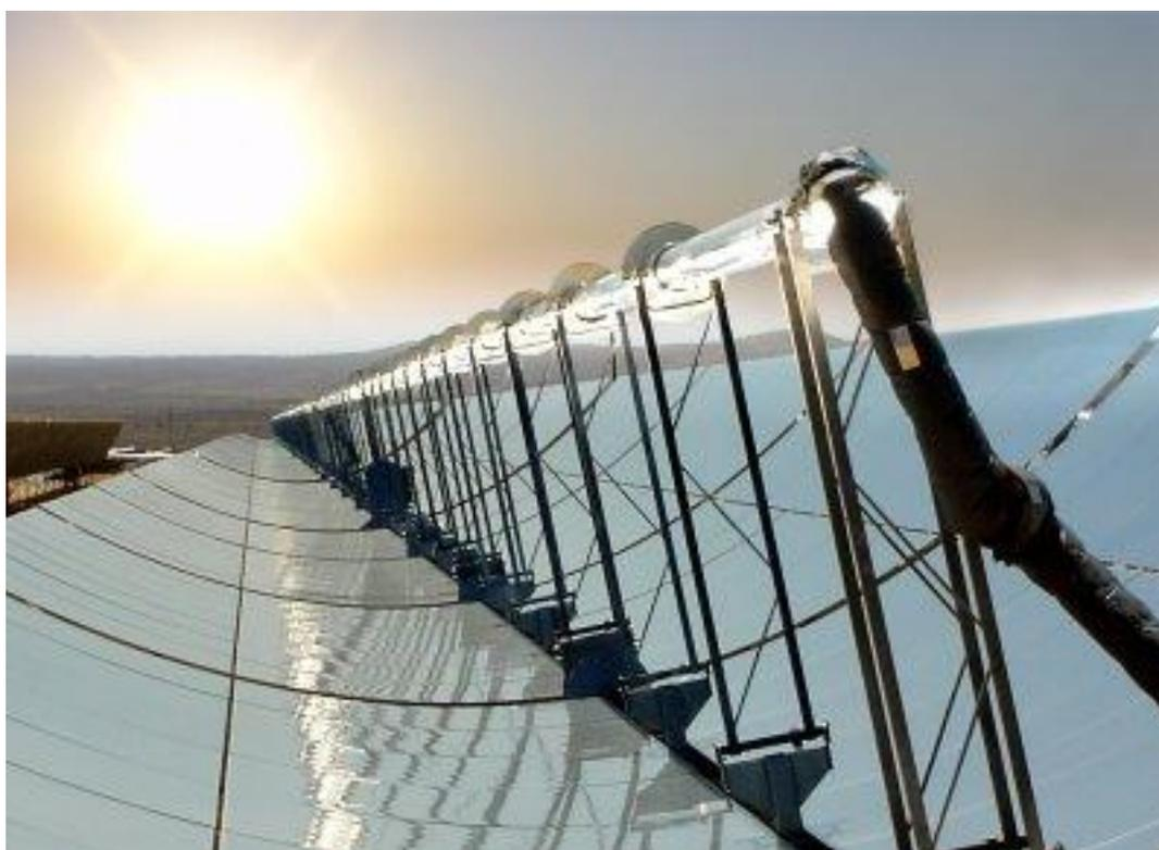
*Figura 5: Reflector cilindro-parabólico*
