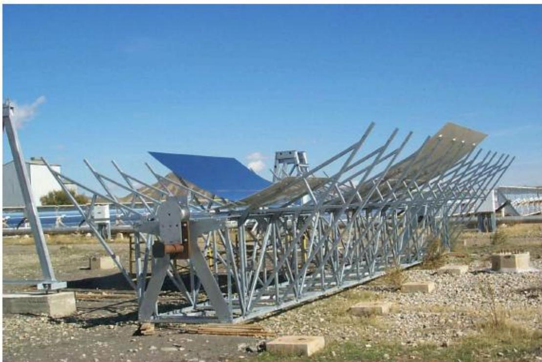
*Figura 54: Vista de la estructura soporte de un captador EUROTROUGH, tomada durante la fase de montaje del espejo. (fuente: “Eurothrough design issues and prototype testing at PSA”, Eckhard Lupfert, M.G., Wolfgang S., Esteban, A., Osuna, R., Zarza, E. and Nava, P. - Proceedings of Solar Forum 2001 Solar Energy: The Power to Choose, April 21-25, 2001, Washington, DC.)*
