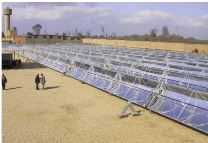
Figura 12: NASR química farmacéutica. Egipto. Capacidad instalada: 1,33 MWth. Fuente: Fichtner Solar GmbH. Alemania
