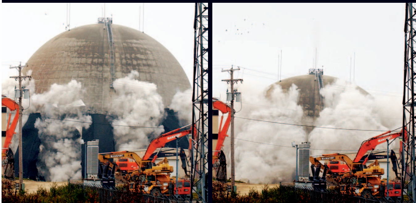
El fin de la antigua cúpula: En septiembre de 2004, los contratistas demolieron la cúpula de contención de la central nuclear de Maine Yankee, ya desactivada, en Wiscasset (Maine). Los escombros se retiraron, pero las barras de combustible del antiguo reactor quedaron detrás, como huérfanas nucleares, dentro de barriles, en la zona abandonada.
