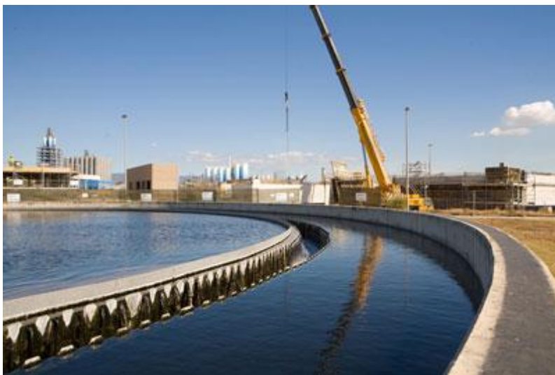
Figura 2: Tratamiento del agua de la Industria Petroquímica
