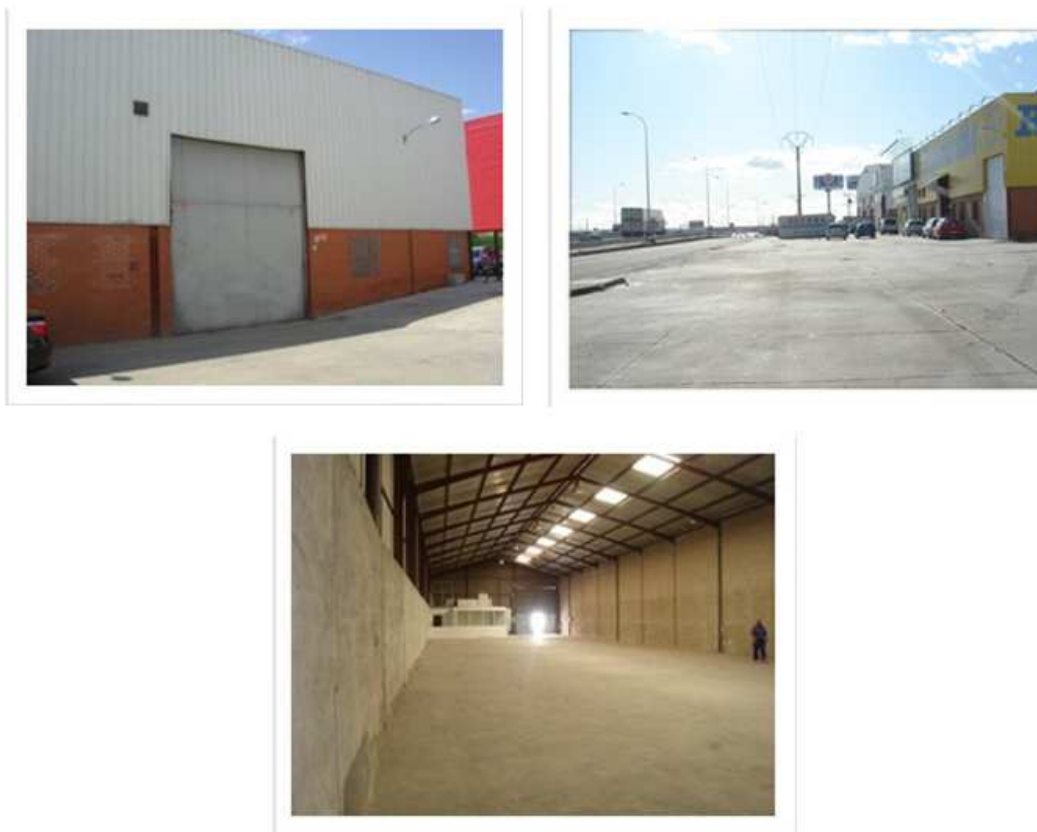
Figura 35. Fotografías de la nave industrial.
