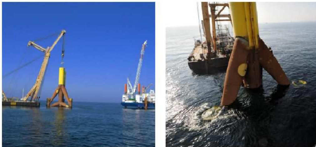
Ilustración 10. Instalación de una cimentación tipo trípode
