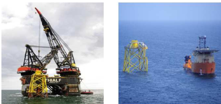
Ilustración 11. Instalación de la estructura de cimentación tipo Jacket
