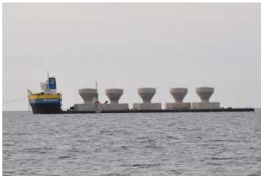
Ilustración 7. Transporte e instalación de una cimentación de gravedad
