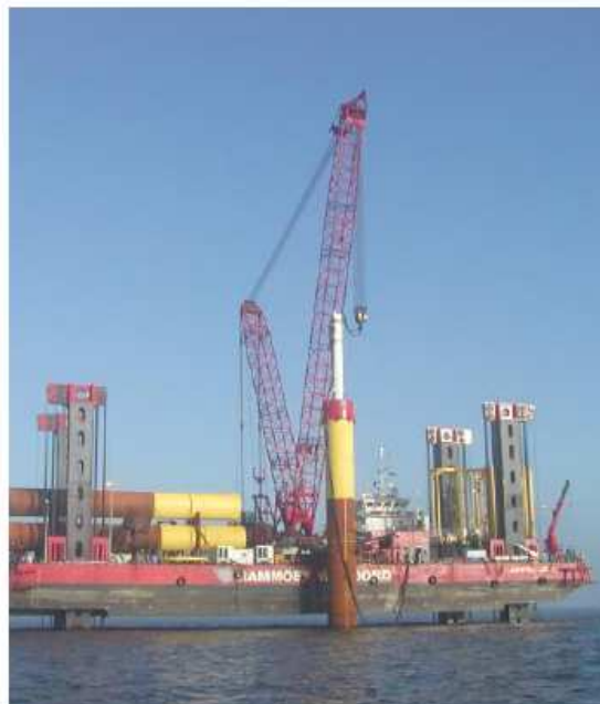
Ilustración 8. Instalación de cimentación tipo monopilote
