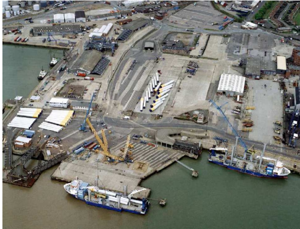
Ilustración 23. Zona de acopio de material
