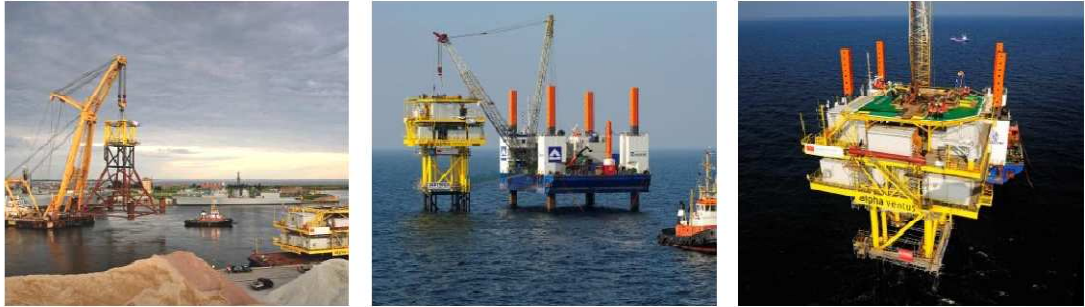
Ilustración 16. Instalación de la subestación transformadora
