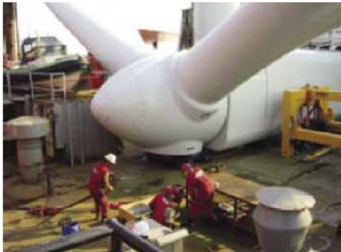
Ilustración 24. Ensamblaje de las palas de un aerogenerador del parque Scroby Sands.
