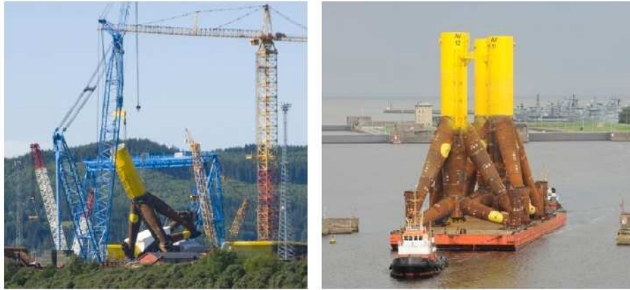
Ilustración 9. Transporte de cimentación tipo trípode hasta su localización
