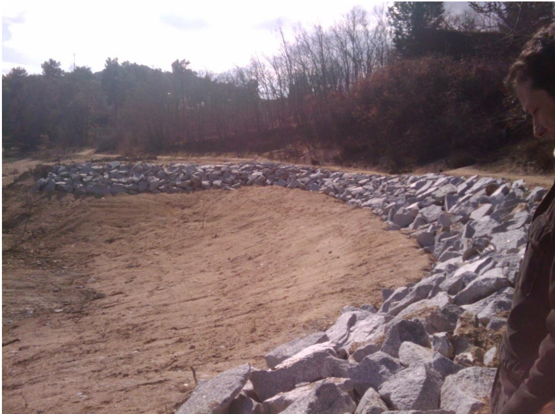
Escollera protectora de la orilla
