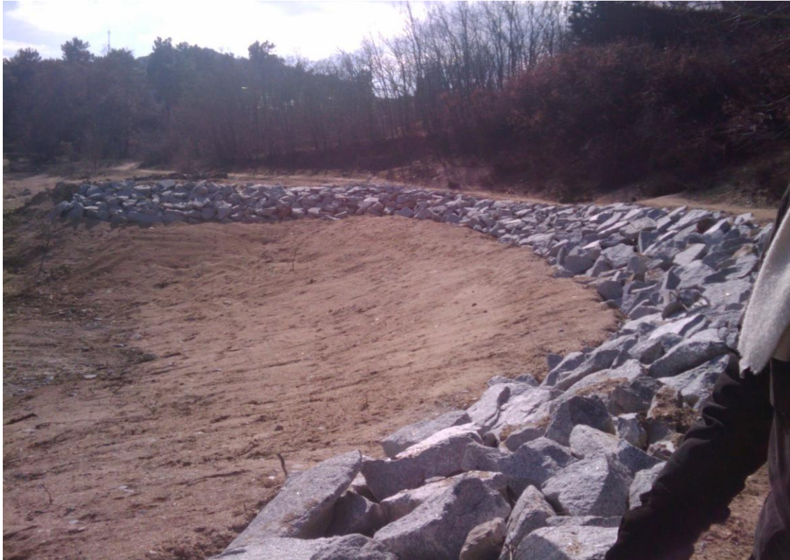
Escollera protectora de la orilla
