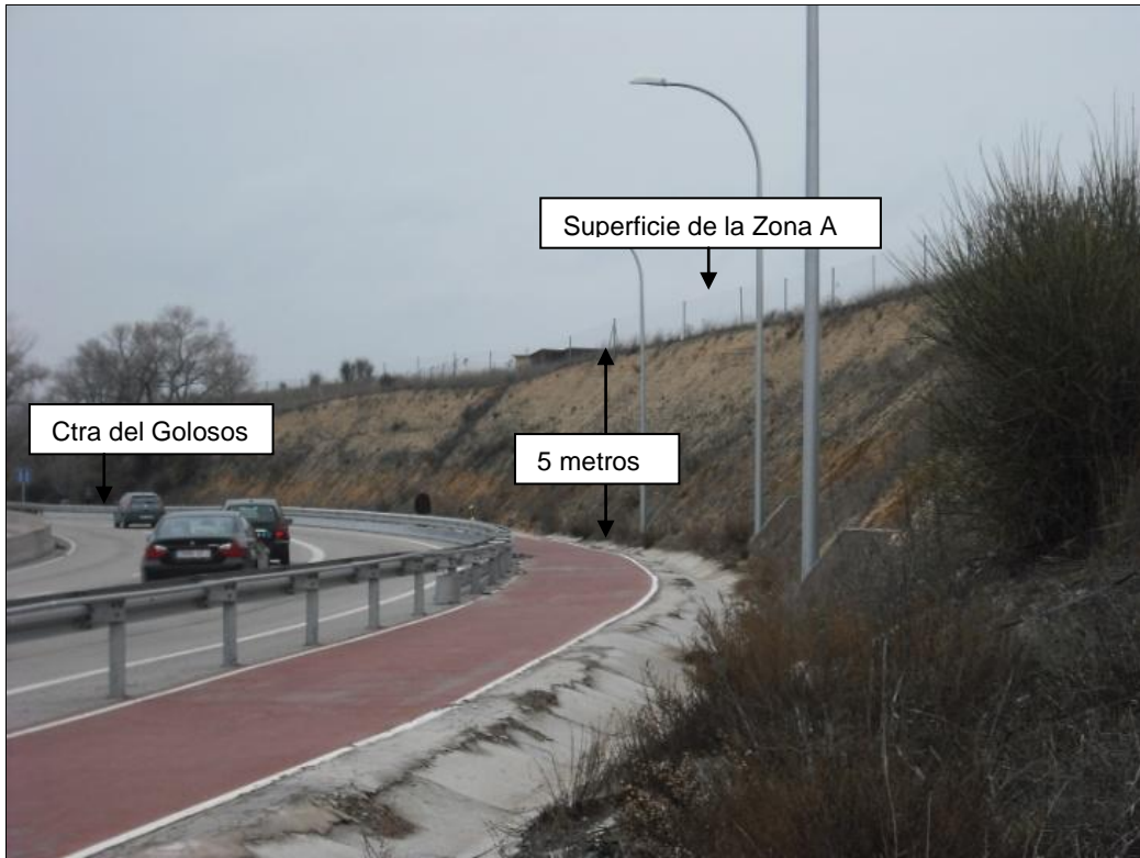
Foto 2. Diferencia de altitud entre la zona A y la carretera del Goloso (M-616)
