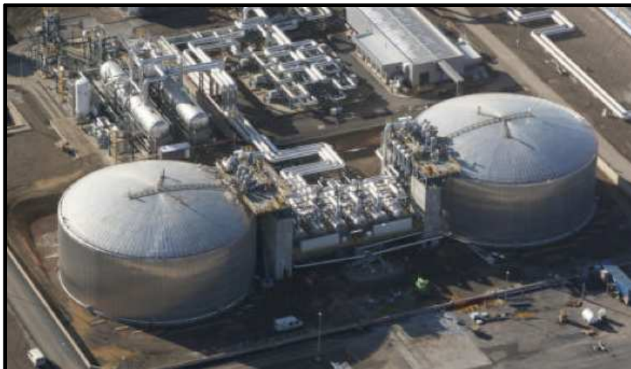
Figura 45: Dos tanques de almacenamiento de sales.
