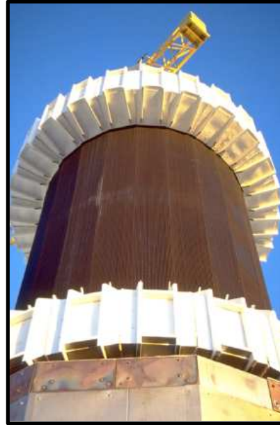
Figura 42: Receptor solar de tipo externo.
