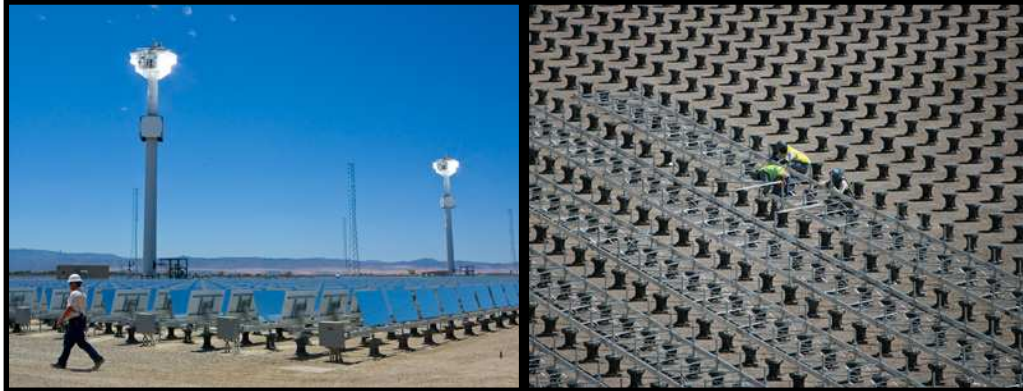
Figura 10: Construcción de la planta multi-torre de eSolar.
