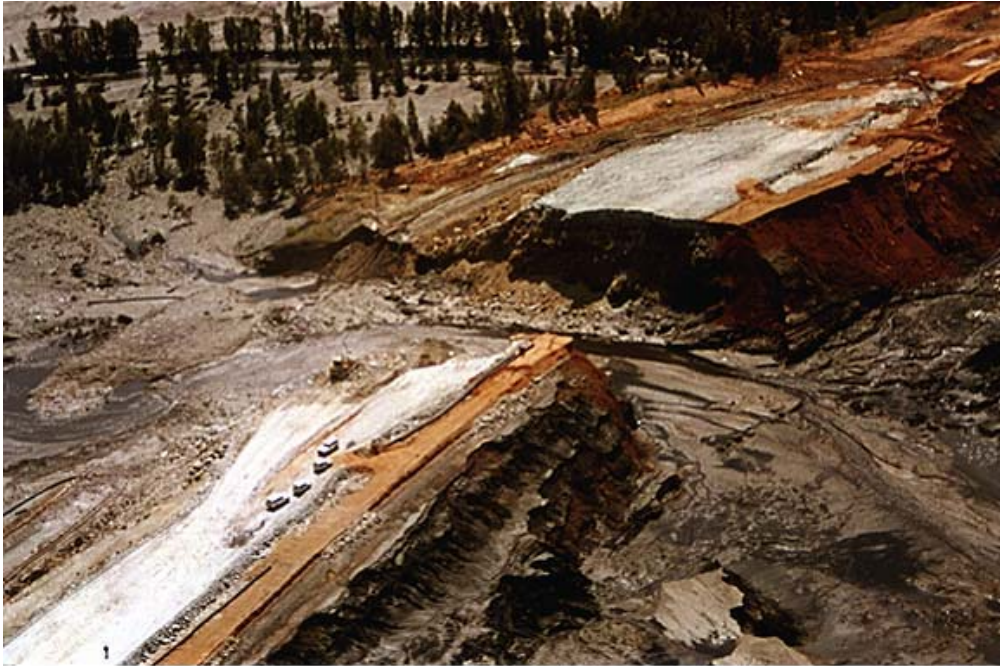
Rotura de la presa de la balsa que contenía los residuos tóxicos en la mina de Aznalcóllar, el día del vertido.
