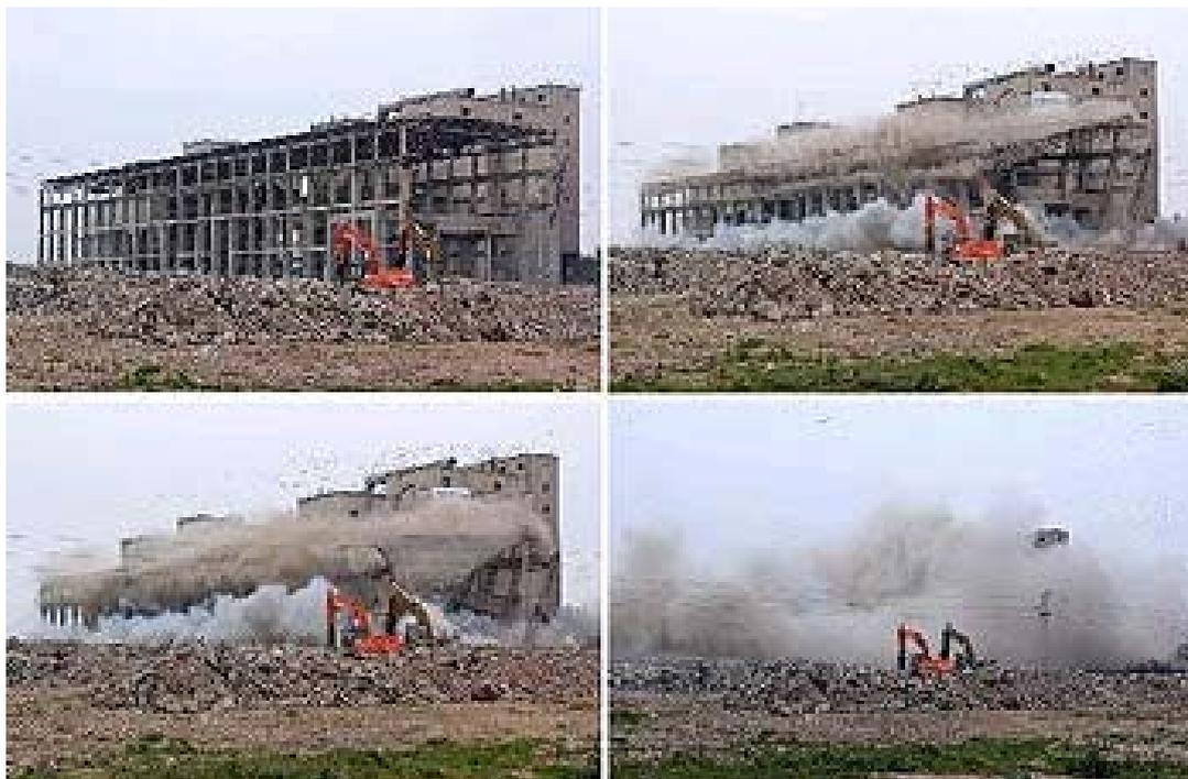
Fig. 1.3: Demolición por voladura
