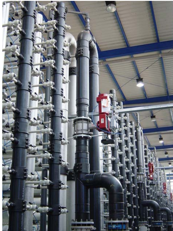
Foto 3 – 8 - 2 Lado de permeado de una desaladora de una etapa.
