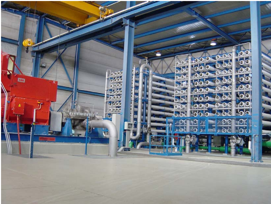
Foto 5. Bastidor de una planta de ósmosis inversa doble etapa (Rambla de Morales).
