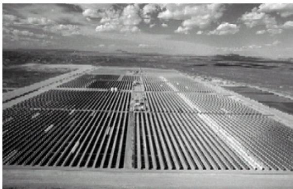
Figura 19. Vista aérea de las plantas SEGS
