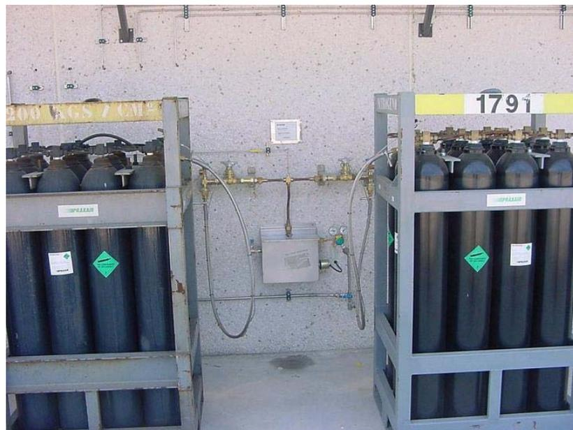
**Figura 24. Suministro de gases industriales en bloques de botellas.**
