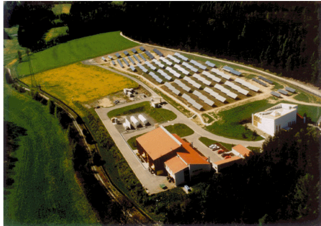
Figura 2-7 : Solar-Wasserstoff-Anlage, Neunburg vorm Wald
