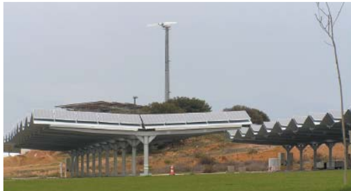
Figura 2-15 : Paneles fotovoltaicos del Parque Tecnológico Walqa
