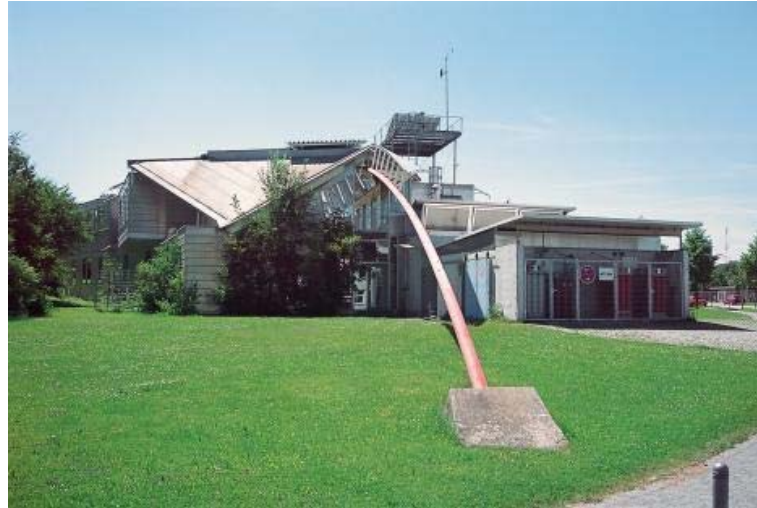
Figura 2-6 : Instalaciones del proyecto HYSOLAR
