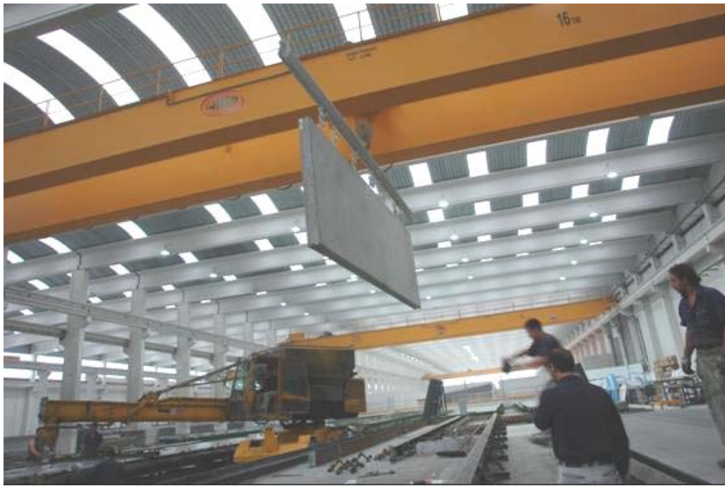
Elevación de paredes.
