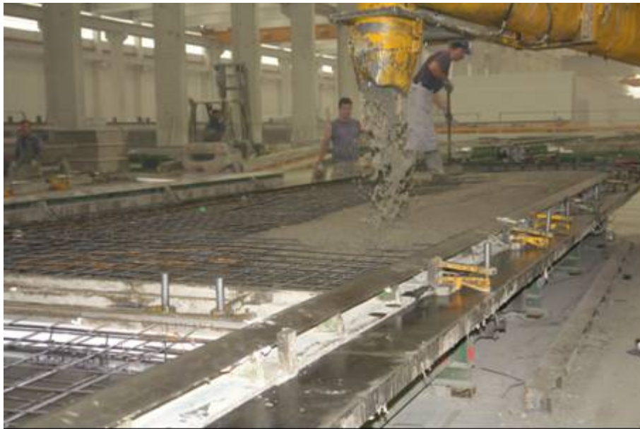
Hormigonado de pared mediante 'Speedy.'
