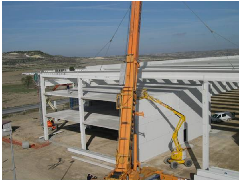
Ilustración de montaje de una nave industrial.
