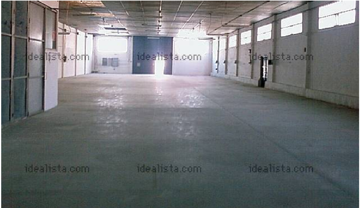
Figura 5-13. – Vista interior de la entrada de la nave industrial
