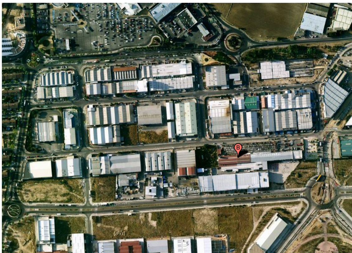
Figura 5-11. – Imagen aérea de polígono industrial Cerro Rubal
