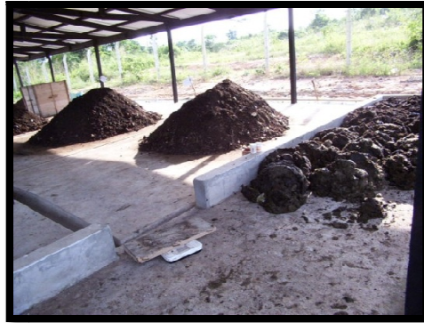
Imagen 14. Eras de secado de lodos de depuración en Ghana. Fuente: www.cipotato.org
