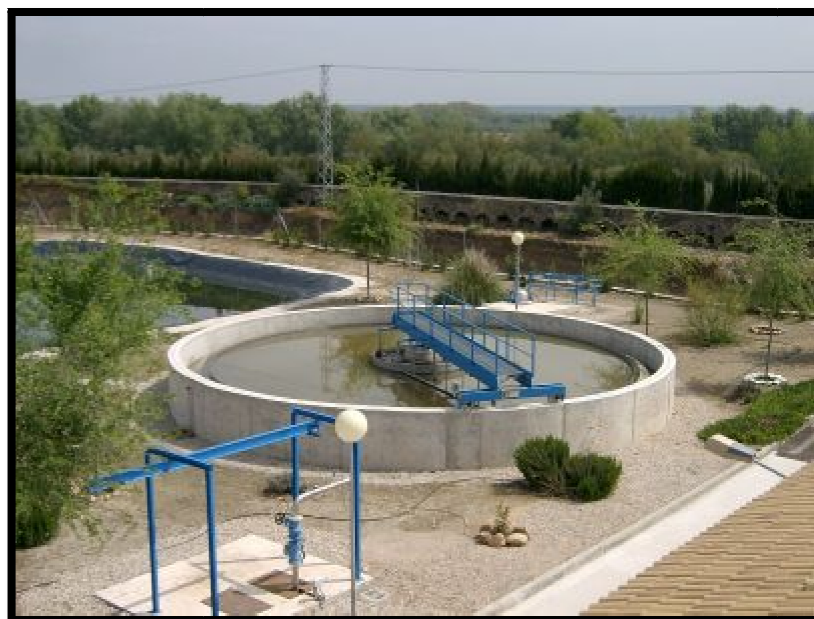
Imagen 12. Decantador secundario circular. Fuente: www.vreina.com
