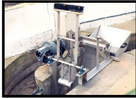
Imagen 9. Reja automática circular. Fuente: www.estruagua.com
