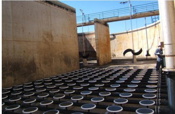
*Figura 14: Imagen de los difusores de un reactor biológico.*
