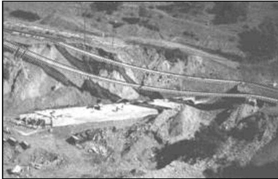
**Figura 11. Obras de reparación del tramo de terraplén del ferrocarril, desmoronado durante la avenida instantánea.**
