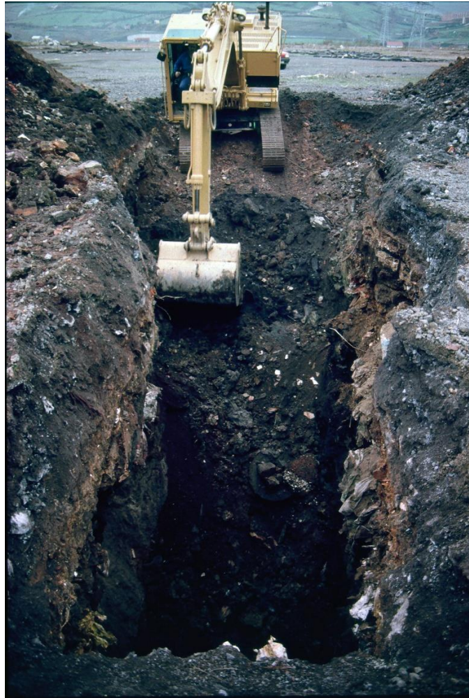
Figura 2.- Cata con retroexcavadora
