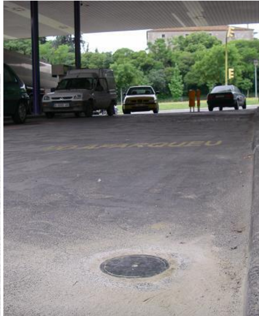
Figura 10.- Arqueta con tapa de un pozo de control
