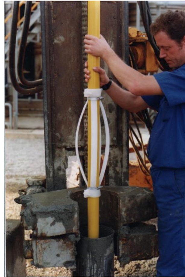
Figura 9.- Instalando el tubo piezométrico
