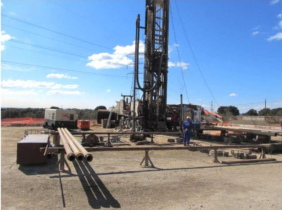
Fotografía nº 3. Máquina de perforación a rotación con circulación inversa, pudiéndose observar el mástil, cabeza de rotación, manguera de lodos y el varillaje.
