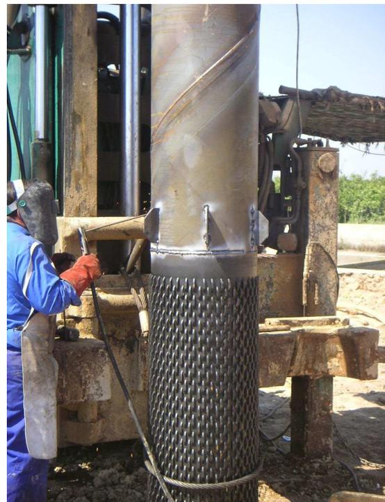
Fotografía nº 5. Se puede observar un acopio de tubería metálica de acero al carbono (alternancia de tramo filtrante de puentecillo y tramo ciego), un tubería filtrante tipo Johnson y la colocación en el interior del pozo del tramo de tubería con la colocación de unos cartabones alrededor de la tubería, que sirven de centradores de la tubería en el interior del sondeo.
