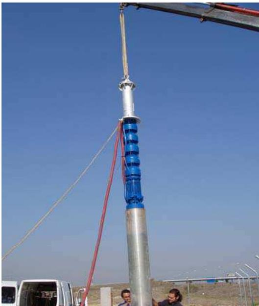
Fotografía nº 7. Montaje del grupo electrobomba sumergible en el pozo.
