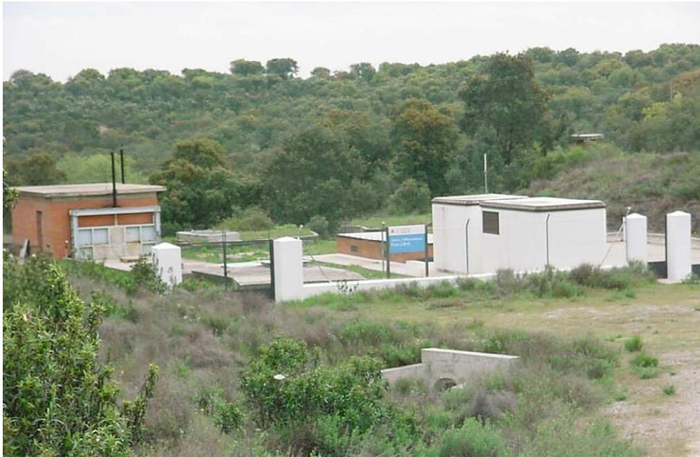
Figura nº 10. Parcela de pozo con los elementos básicos: centros de alta tensión y de control, arqueta del pozo y cerramiento de la parcela.
