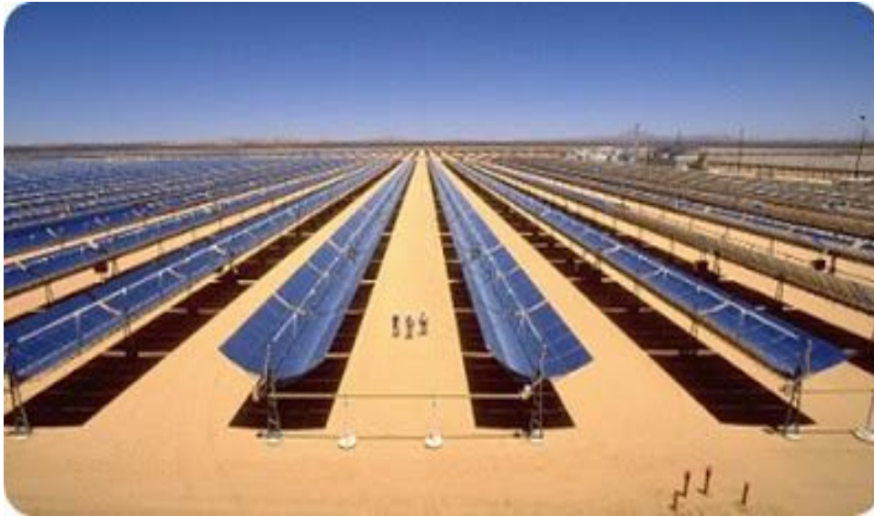
Figura 22 - Ejemplo típico de una distribución del diseño de un campo solar.
