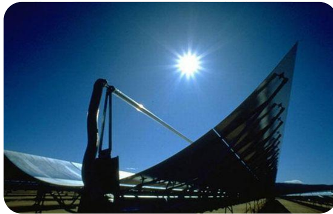
Figura 19 - Concentración en el tubo receptor de la radiación solar reflejada por el concentrador.
