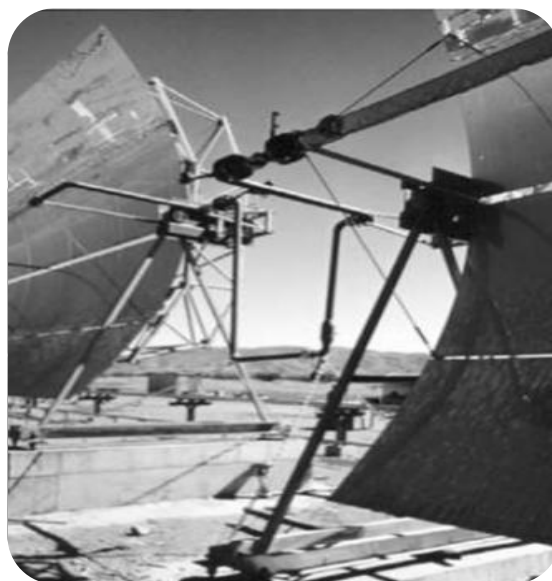
Figura 23 -Acoplamiento entre captadores mediante juntas rotativas
