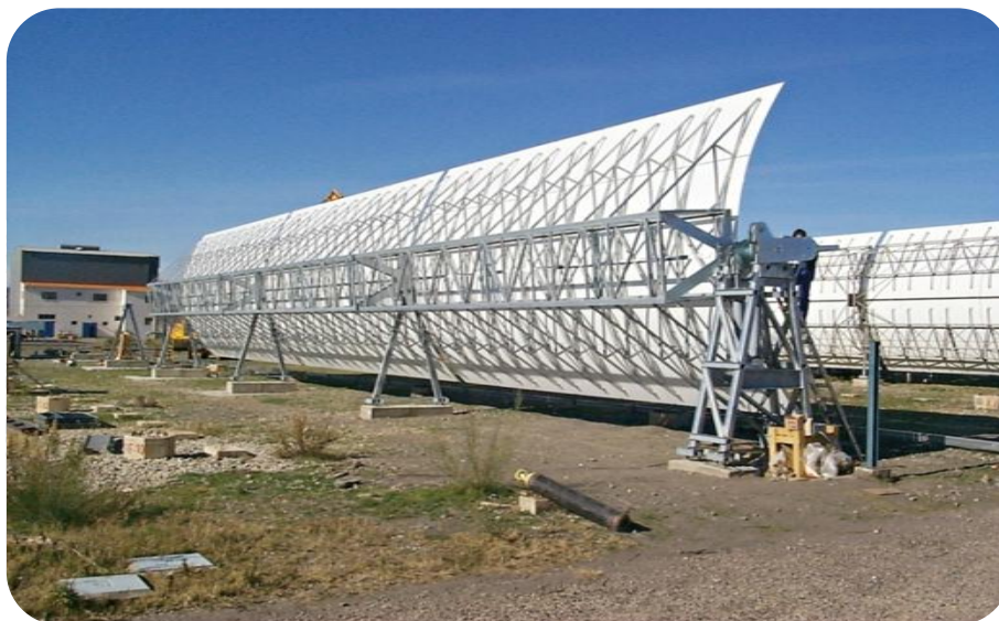
Figura 40 - Estructura del EUROTROUGH 150.
