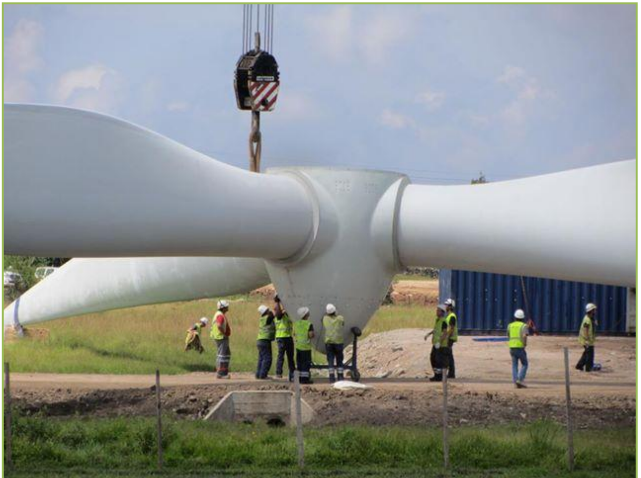
Figura 102: Momento de elevación del cono y palas de un aerogenerador.
