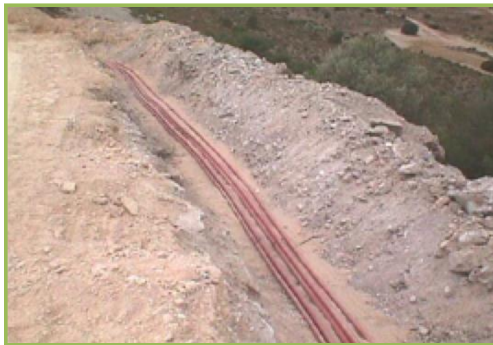
Figura 101: Zanjado para el cableado eléctrico.
