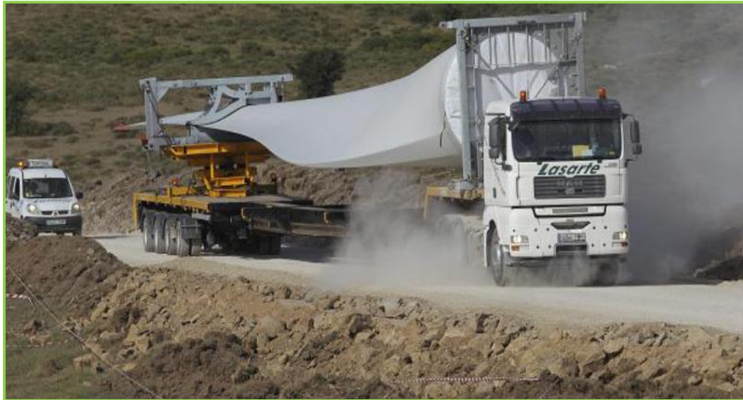
Figura 37: Camión transportando pala por vial de zahorra
