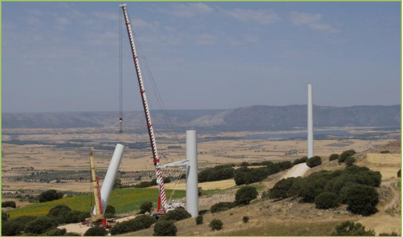
Figura 104: Uso de grúas para la instalación de torres de aerogeneradores.
