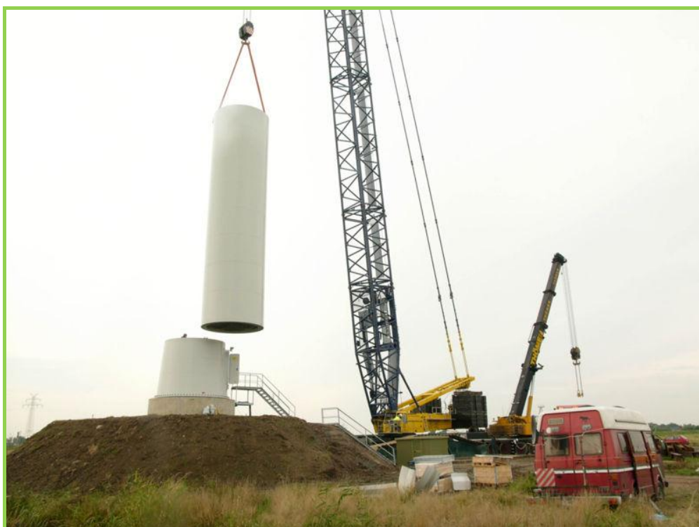
Figura 49: Colocación del primer tramo sobre la base.
