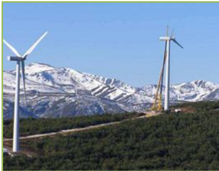
Figura 99: Instalación de aerogeneradores. Detalle de caminos de acceso.
