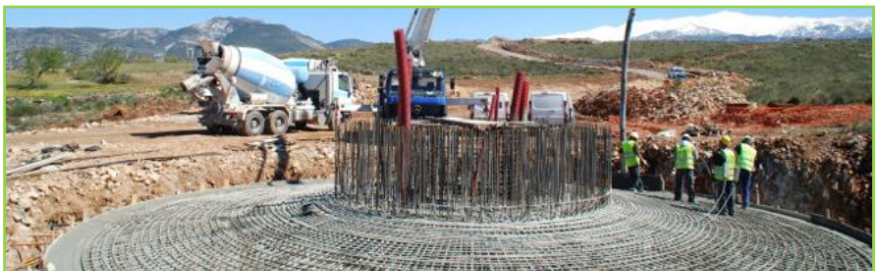
Figura 45: Detalle de cimentación para el aerogenerador
