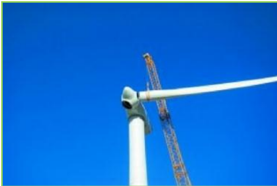
Figura 53: Colocación de una de las palas
