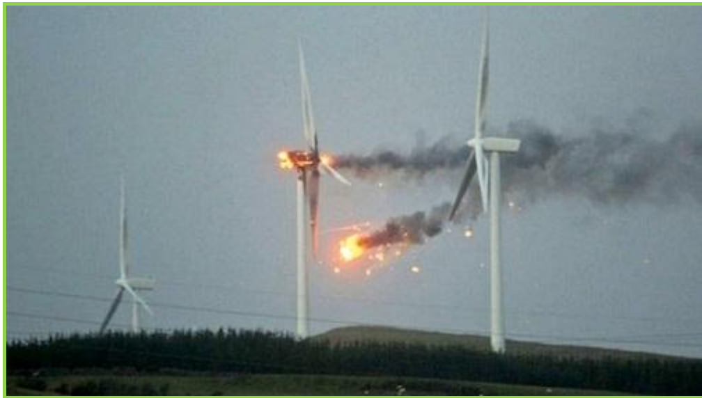
Figura 110: Incendio de un aerogenerador.
