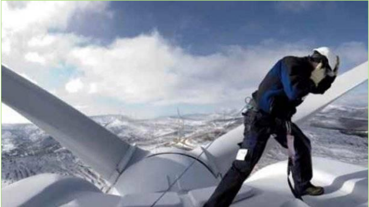
Figura 108: Personal utilizando el arnés, para inspeccionar el aerogenerador.
