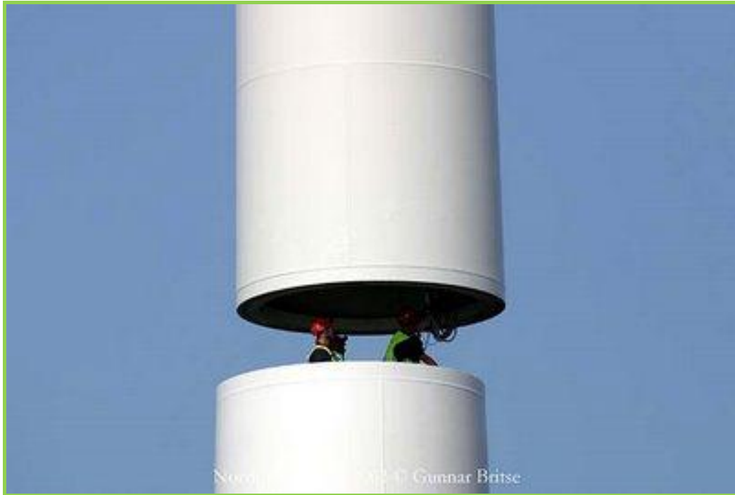
Figura 50: Ensamblaje del primer tramo con el segundo tramo de la torre
