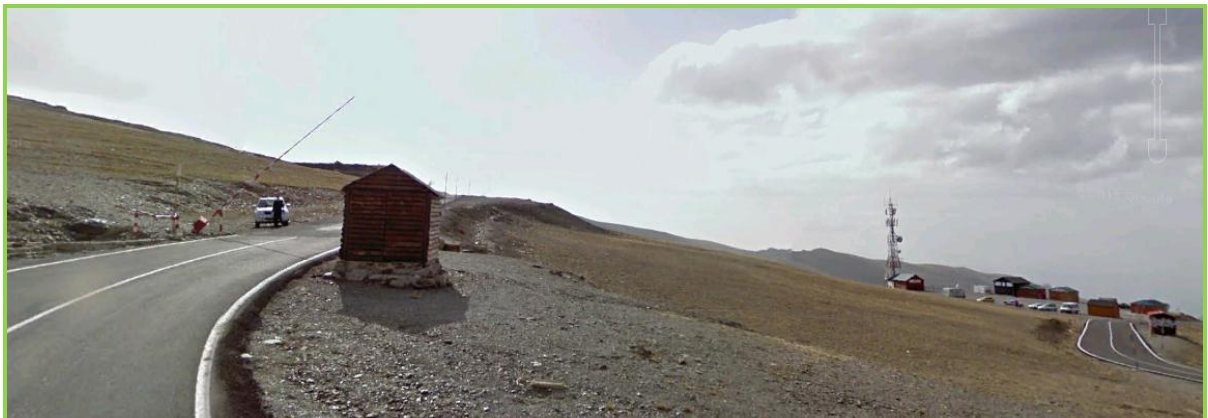
Figura 36: Último tramo antes de vial de zahorra
