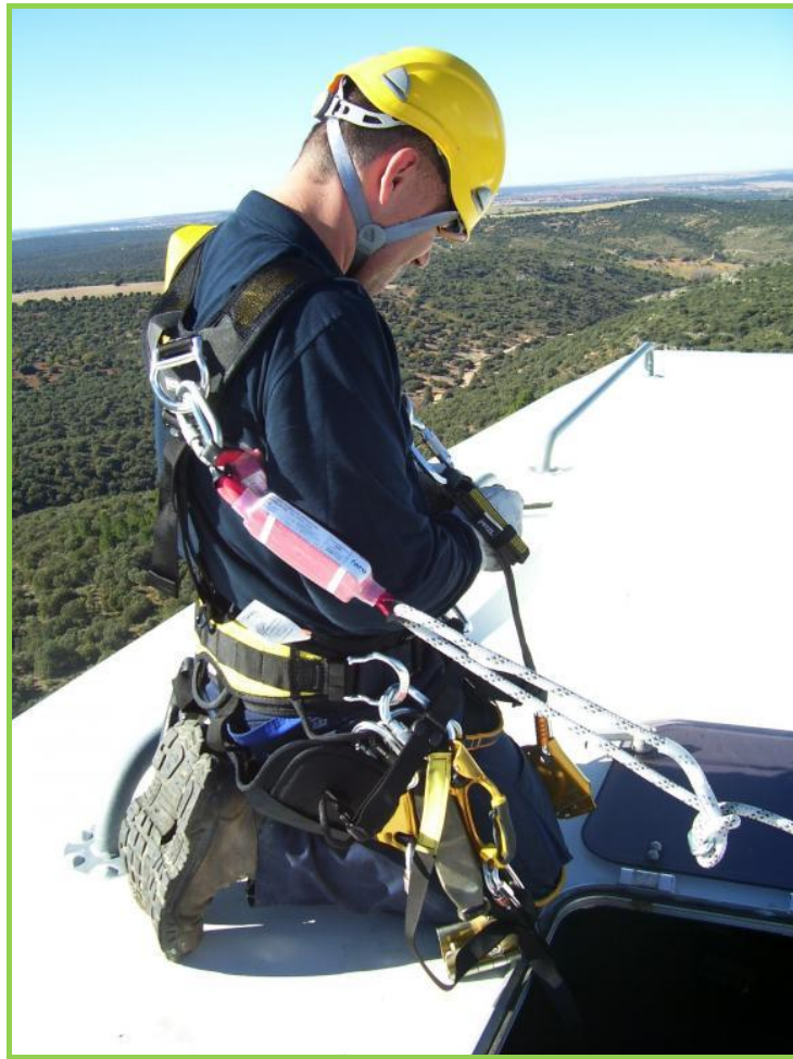
Figura 107: Mantenimiento de un aerogenerador. Equipo de protección personal.
