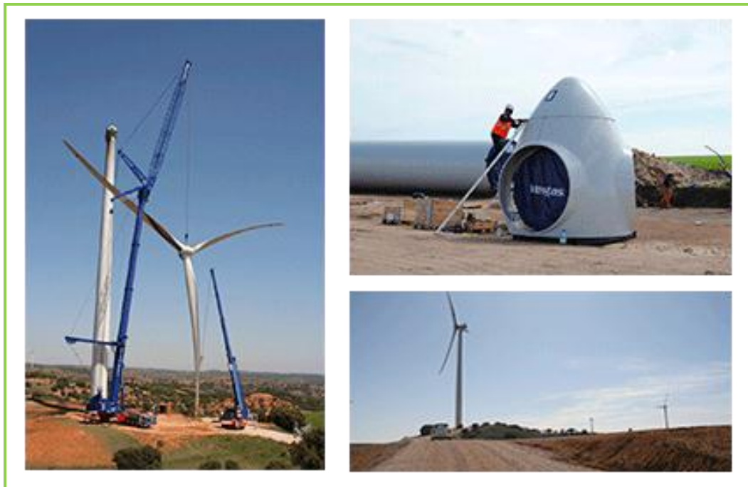
Figura 54: Montaje con grúa telescópica
