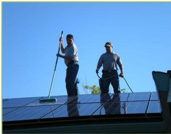
Figura 78: Personal realizando una limpieza básica al sistema fotovoltaico.
