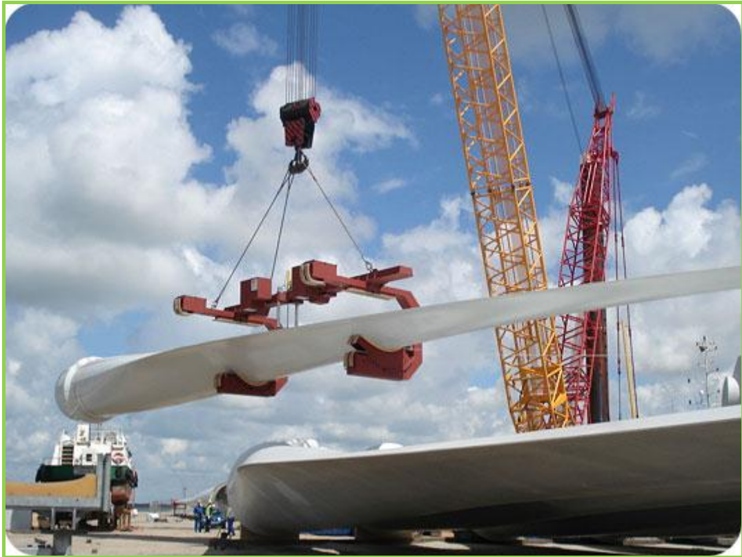
Figura 52: Elevación de una de las tres palas
