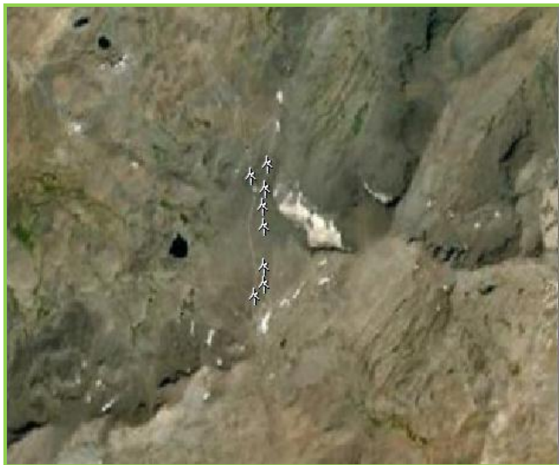
Figura 64: Vista de la posición de los aerogeneradores
