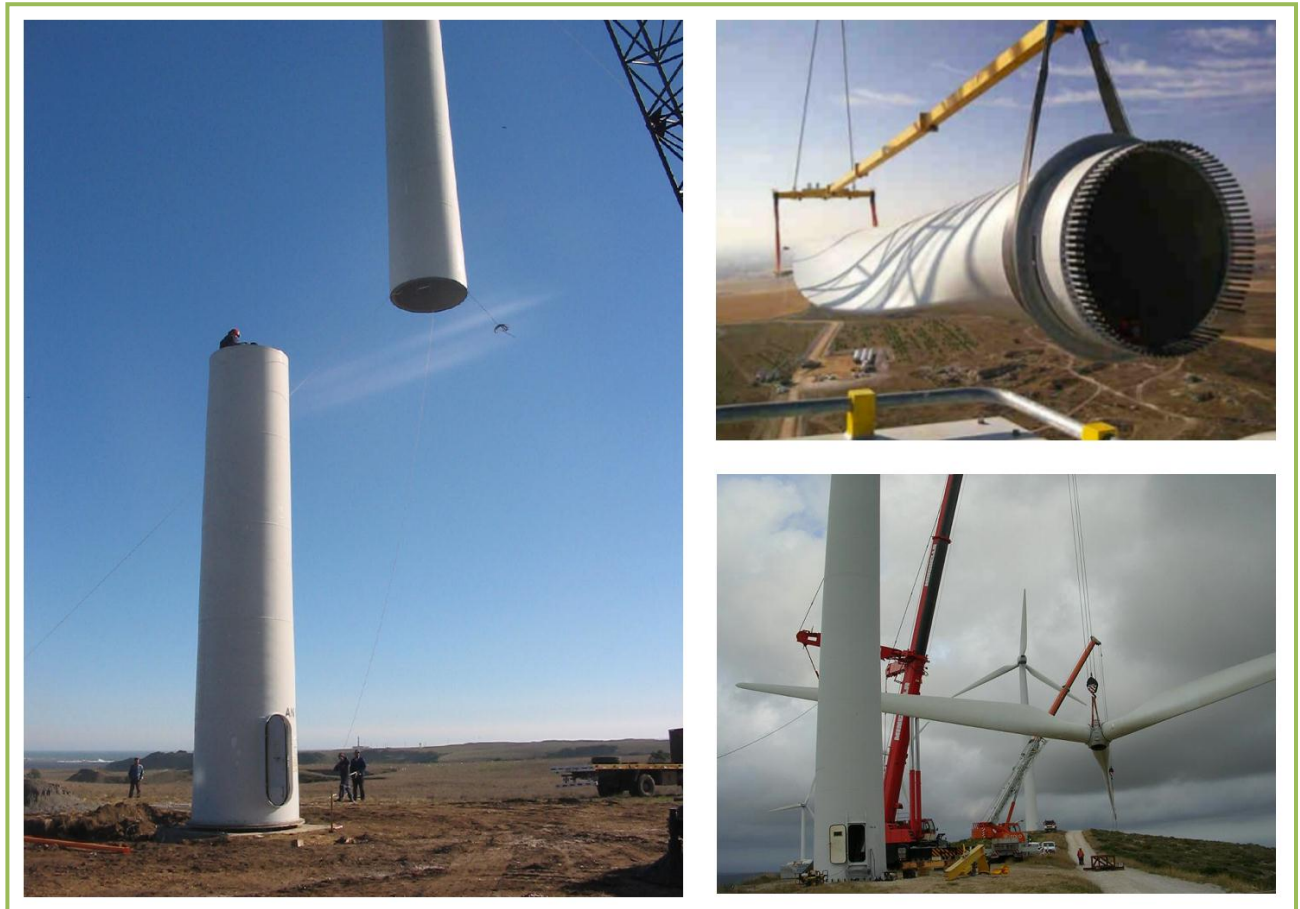
Figura 103: Izado de elementos de un aerogenerador.
