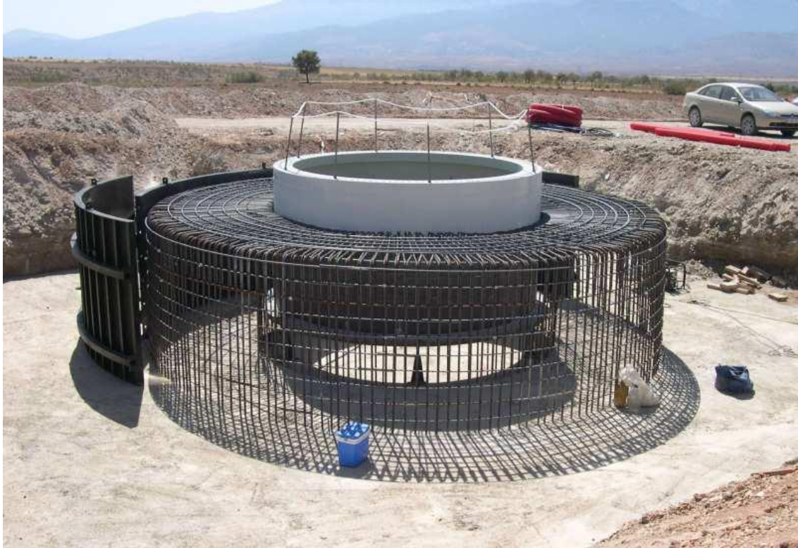
Figura 100: Cimentación de un aerogenerador.
