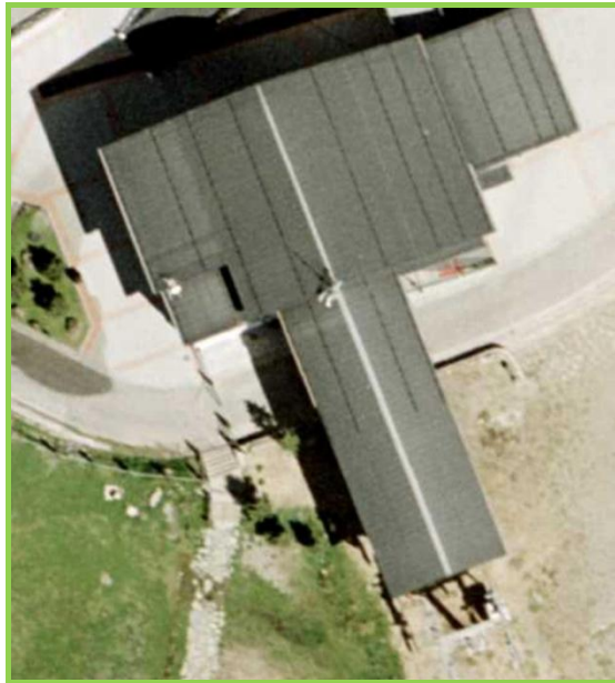
Figura 65: Cubierta estación de Sierra Nevada
