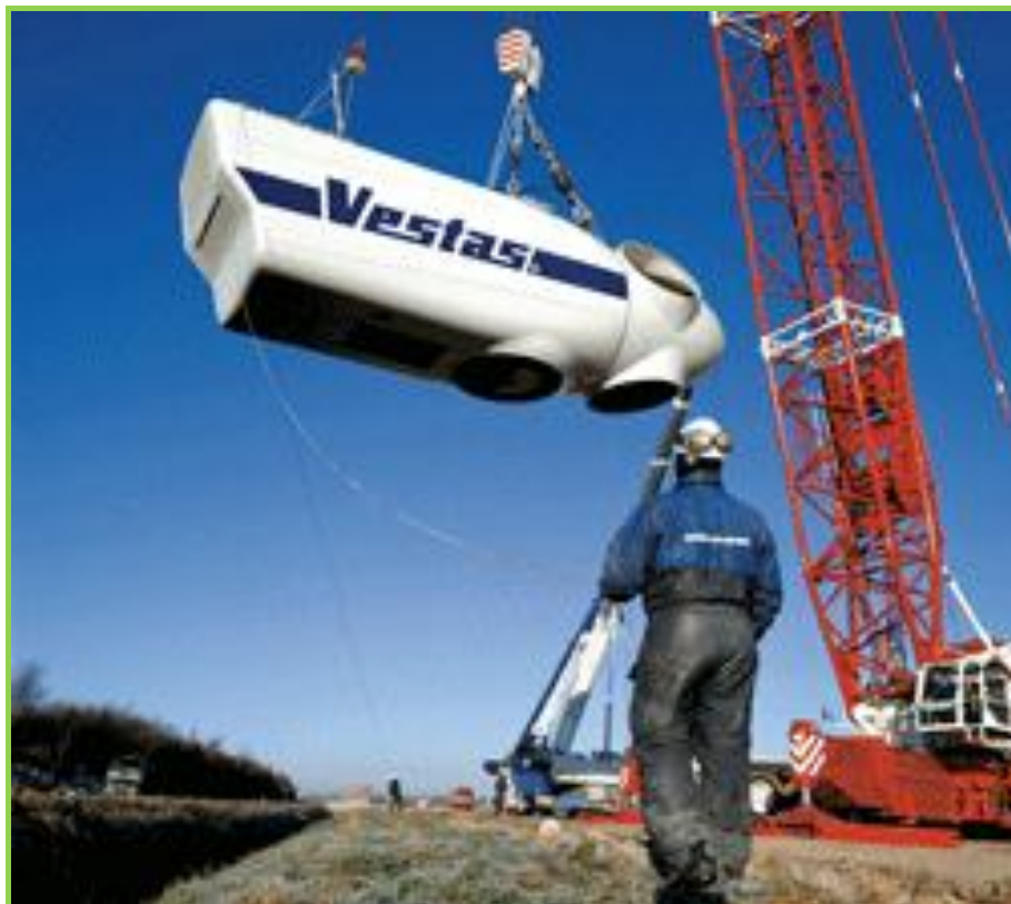
Figura 51: Elevación y colocación de la nacelle
