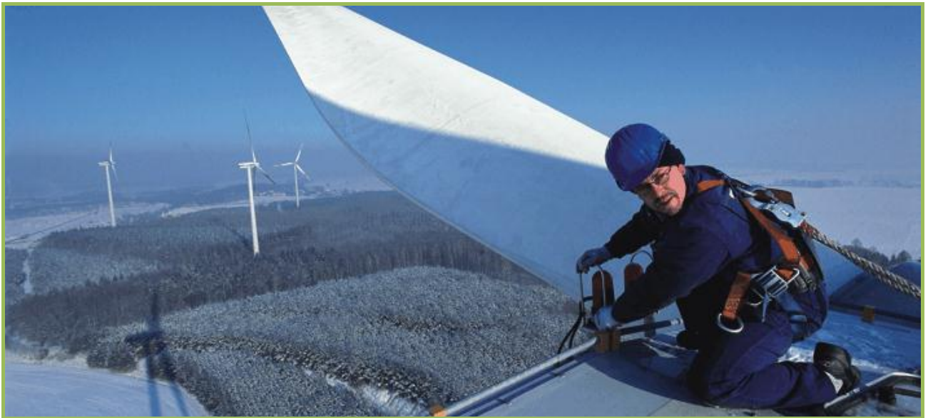
Figura 77: Personal realizando un mantenimiento al aerogenerador.
